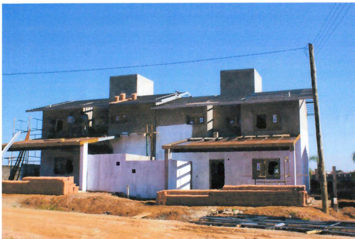
Figura 18. Cobertura das casas com estrutura metálica e da garagem com estrutura de madeira
