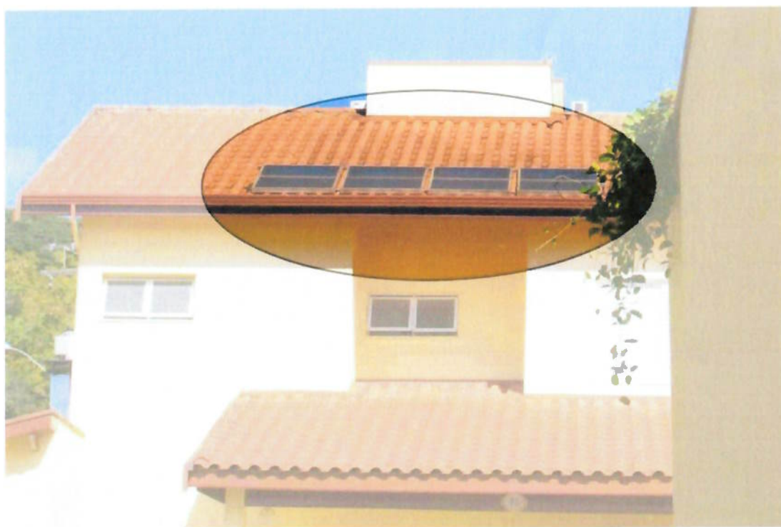
Figura 31. Placas coletoras instaladas em casa do condomínio pelo morador
