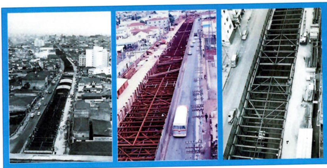
Figura 29 – Construção dos túneis do trecho Jabaquara – Vila Mariana da Linha 1-Azul do Metrô de São Paulo, entre 1968 e 1971 – método VCA (METRÔ, 2012)
