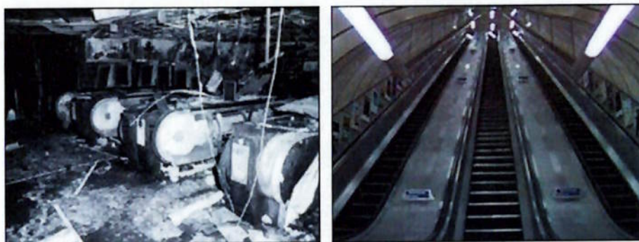
Figura 2 – Escadarias rolantes de acesso à Linha Piccadilly , na Estação King's Cross , em Londres, logo após o acidente (esquerda), e atualmente (BBC NEWS, 2008).
