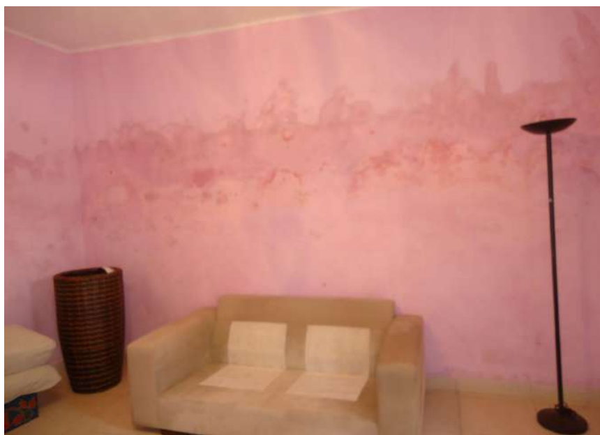
Figura 38: Marca d'água na parede da casa da moradora na Av. Teresa Cristina (Trecho 1) após o evento de março de 2019. Fonte: Autora, 2019
