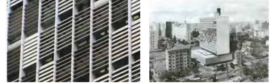
Figura 25: Edifício Banco Sulamericano, projeto de Rino Levi (1963) Fonte: Acervo Labaut-FAUUSP, 2015
