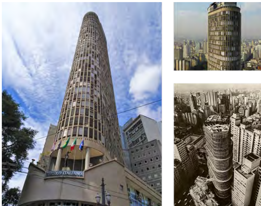
Figura 26: Edifício Itália, projetado por Franz Heep Fonte: Acervo Labaut-FAUUSP, 2015
