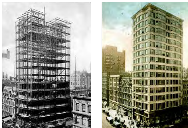
Figura 2: Reliance Building , projetado pelo escritório Burnham and Root (1895) Fonte: Chicagology, disponível em < https://chicagology.com/goldenage/goldenage032/ > Acesso em jun/2020
