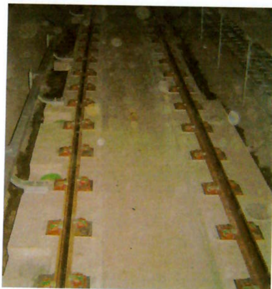
Figura 13 – Disposição dos Isoamortecedores ao Longo da Via
