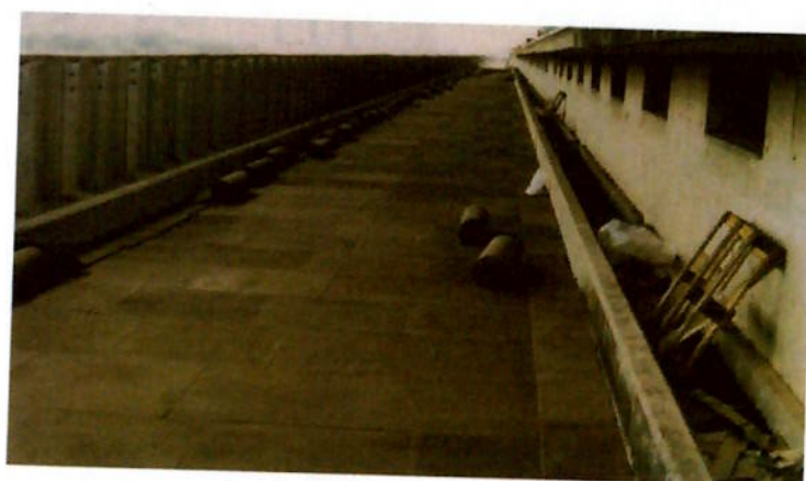
Figura 11 – Manta Elastomérica Antivibratória Sob Lastro
