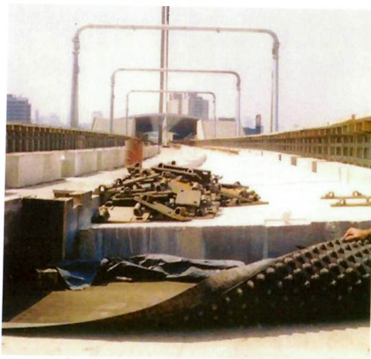
Figura 9 – Detatalhe da Manta Sob Laje Flutuante
