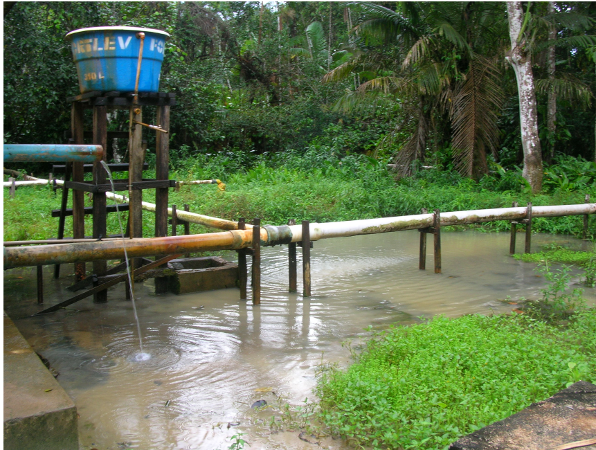
Figura 36. Alagamento da região onde situam-se os poços de captação da COSANPA, após ocorrência de chuva.
