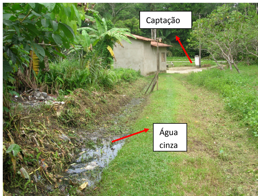
Figura 34. Encosta à montante da captação da COSANPA. FONTE: Arquivo próprio.
