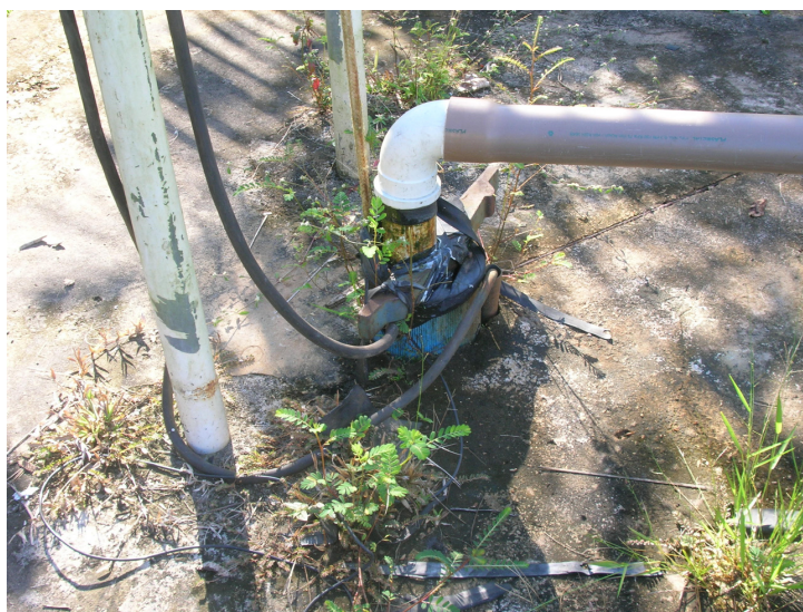
Figura 39. Canalização saindo de poço de micro sistema de Ananim; existência laje de cobertura.
