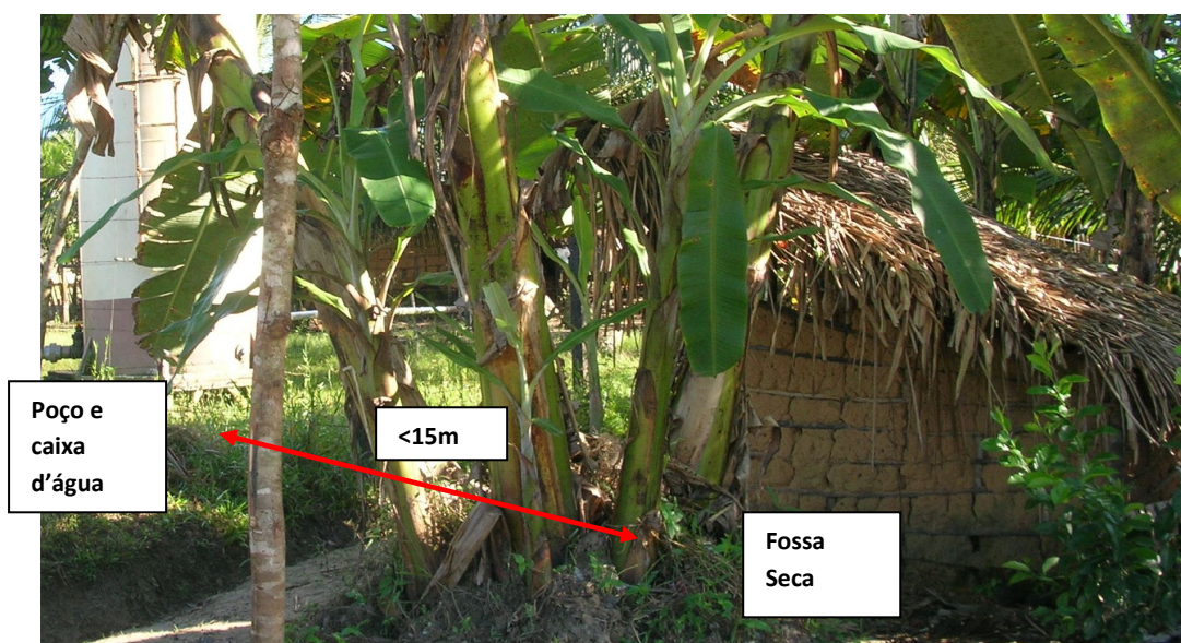
Figura 33. Fossa seca a menos de 15 metros de distância do poço de captação da comunidade de Ananim.
