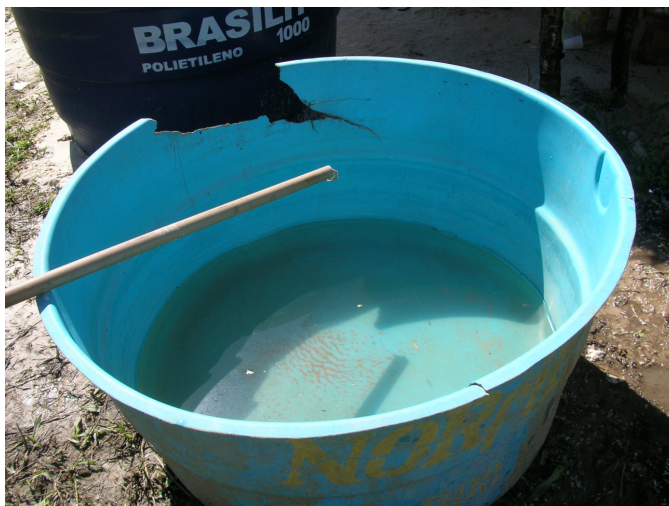
Figura 45. Reservatório existente em escola da comunidade de Salgado, com água de aparência turva, deposição de areia e formação de crostas.
