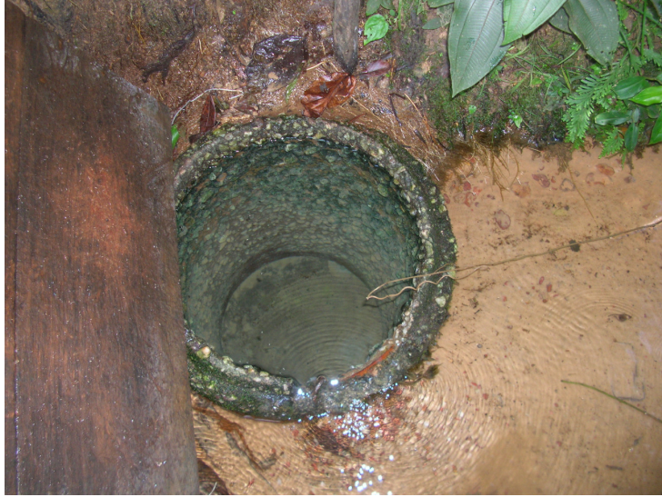
Figura 27. Cacimba utilizada pelos moradores como alternativa ao sistema de abastecimento da COSANPA. FONTE: Arquivo próprio.
