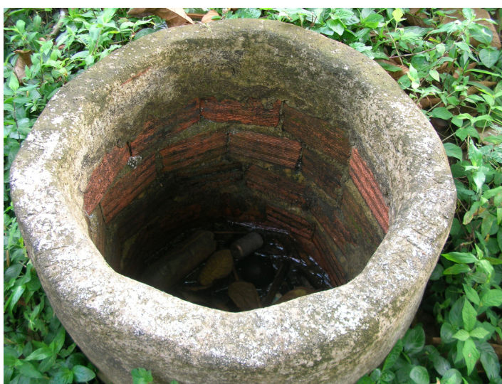
Figura 30. Cacimba existente no bairro Eliolândia, atualmente não utilizada para captação de água, mas que compreende um ponto de contaminação da água subterrânea.
