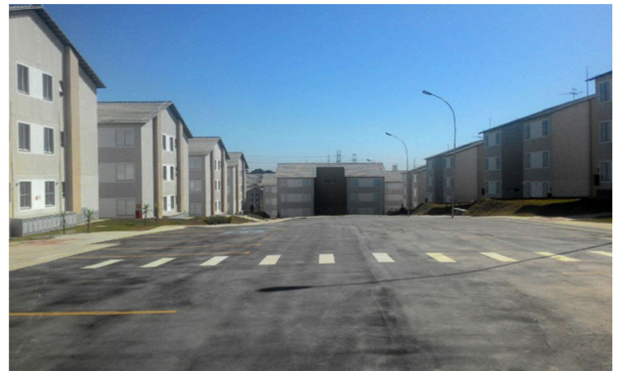
Figura 130 – Imagem do bolsão de estacionamentos disponibilizada no Google Maps, 2017. Fonte: Eliete Almeida
