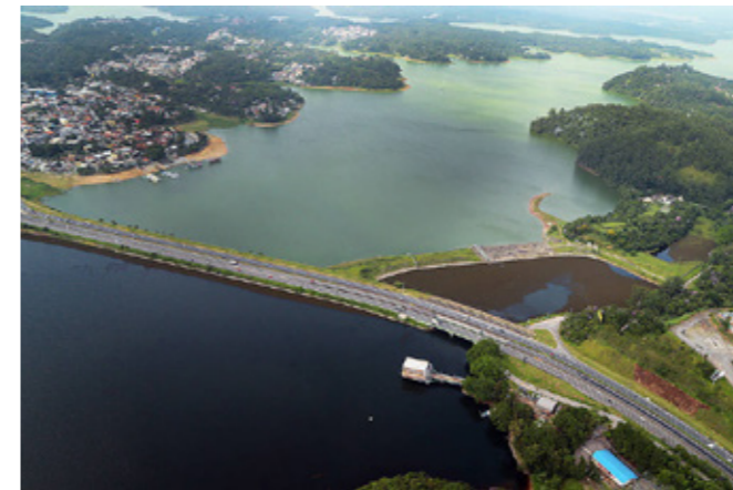
Figura 06 – Barragem na Rod. Anchieta que divide a Represa Billings. Fonte: neste Link
