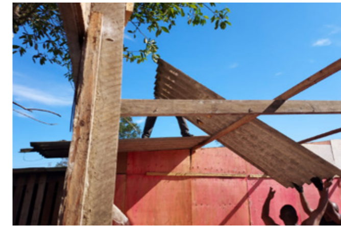
Figura 62 – Remoção de telhas na demolição de um barraco. Acervo do autor
