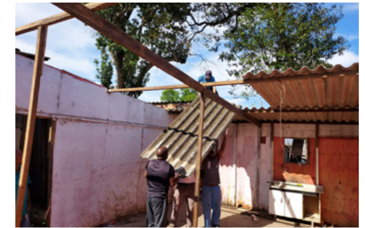
Figura 63 – Remoção de telhas na demolição de um barraco. Acervo do autor
