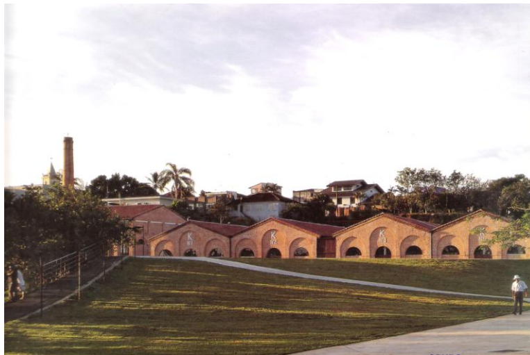
Figura 7 - Foto recente do Conjunto de Galpões da K.K.K.K restaurados e transformados em Centro Cultural. em Registro/SP. Autor: Nelson Kon. Fonte: SAGAWA, Hugo. O conjunto KKKK. São Paulo: Takano Editora, 2002.
