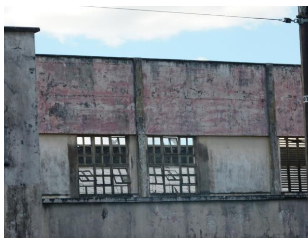
Figura 22 – Detalhe das janelas e da ausência de cobertura, que evidenciam a ação da deterioração da antiga Usina de Chá da C.A.C. Larissa Rocha, 2013.
