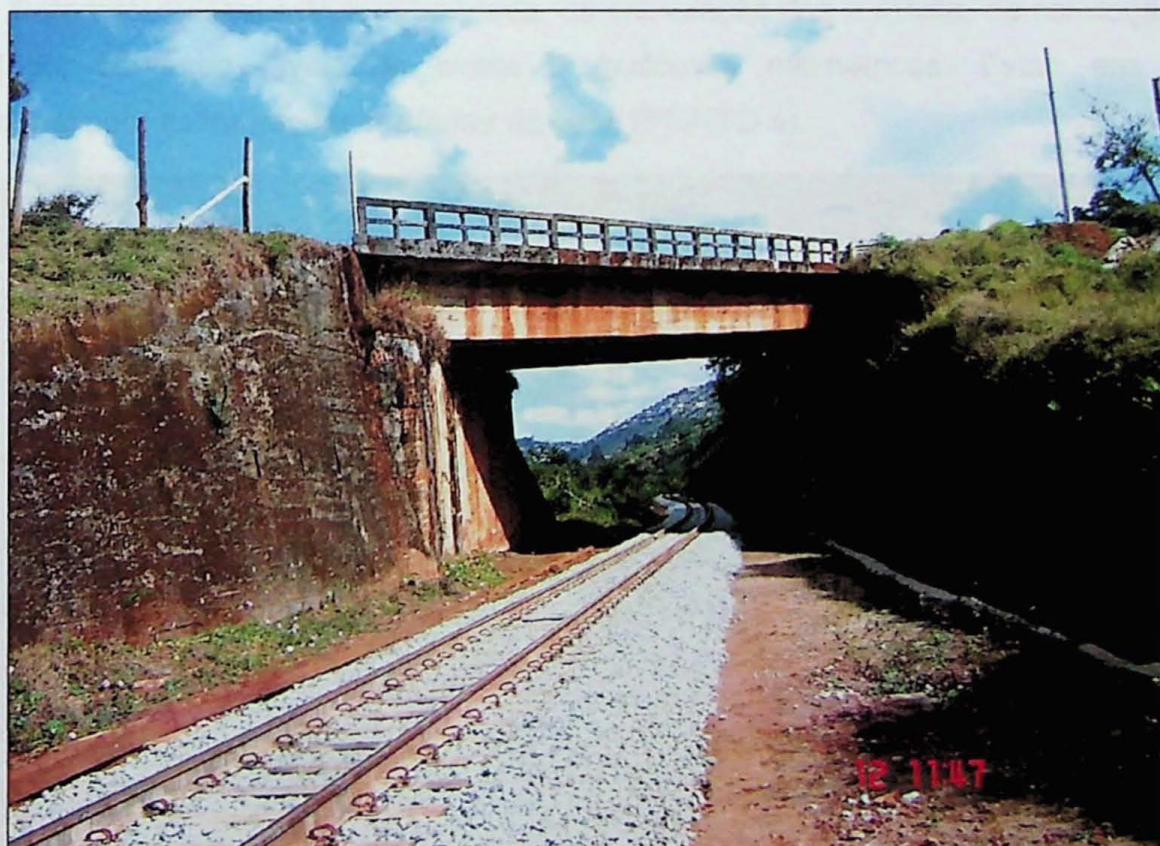
Figura 9 - Cruzamento da Estrada de Ferro com a Rodovia Ouro Preto.
