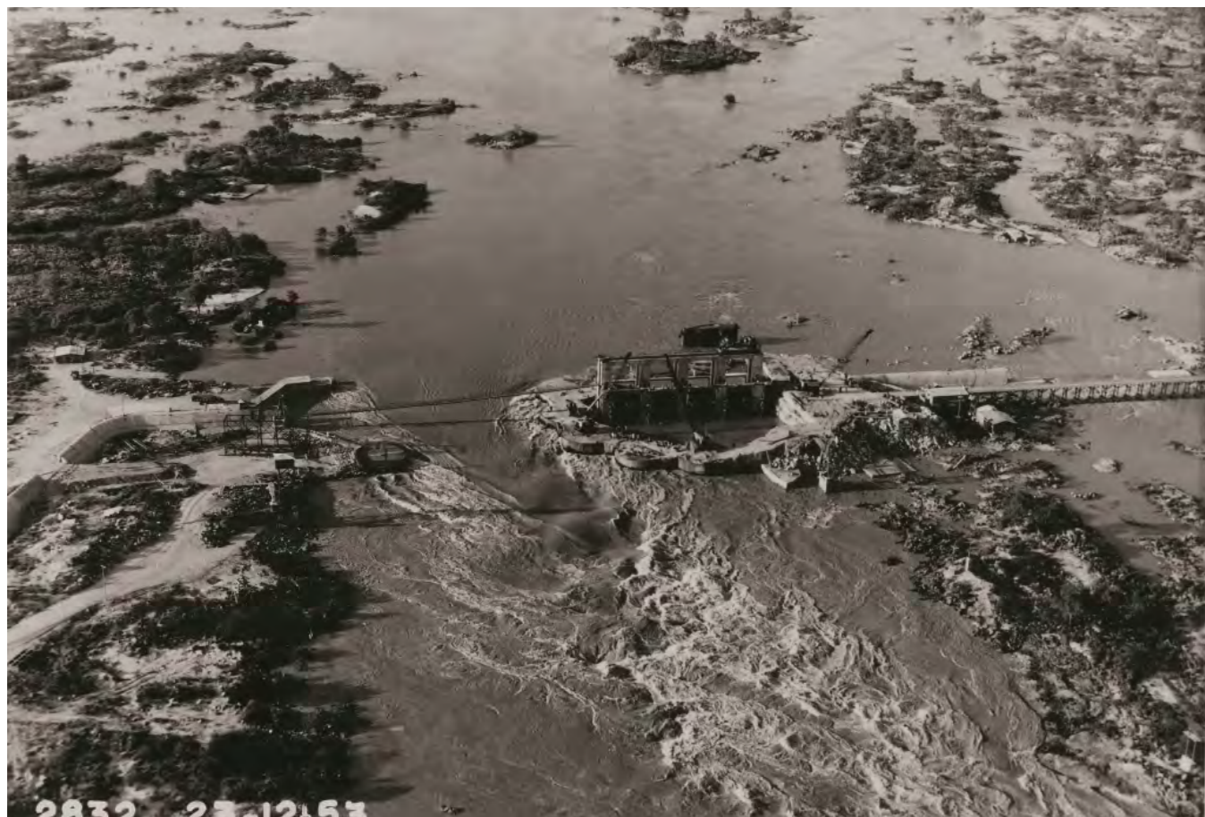
Fig. 14. Construção Usina Hidrelétrica de Paulo Afonso I. Foto: Memorial da eletricidade
