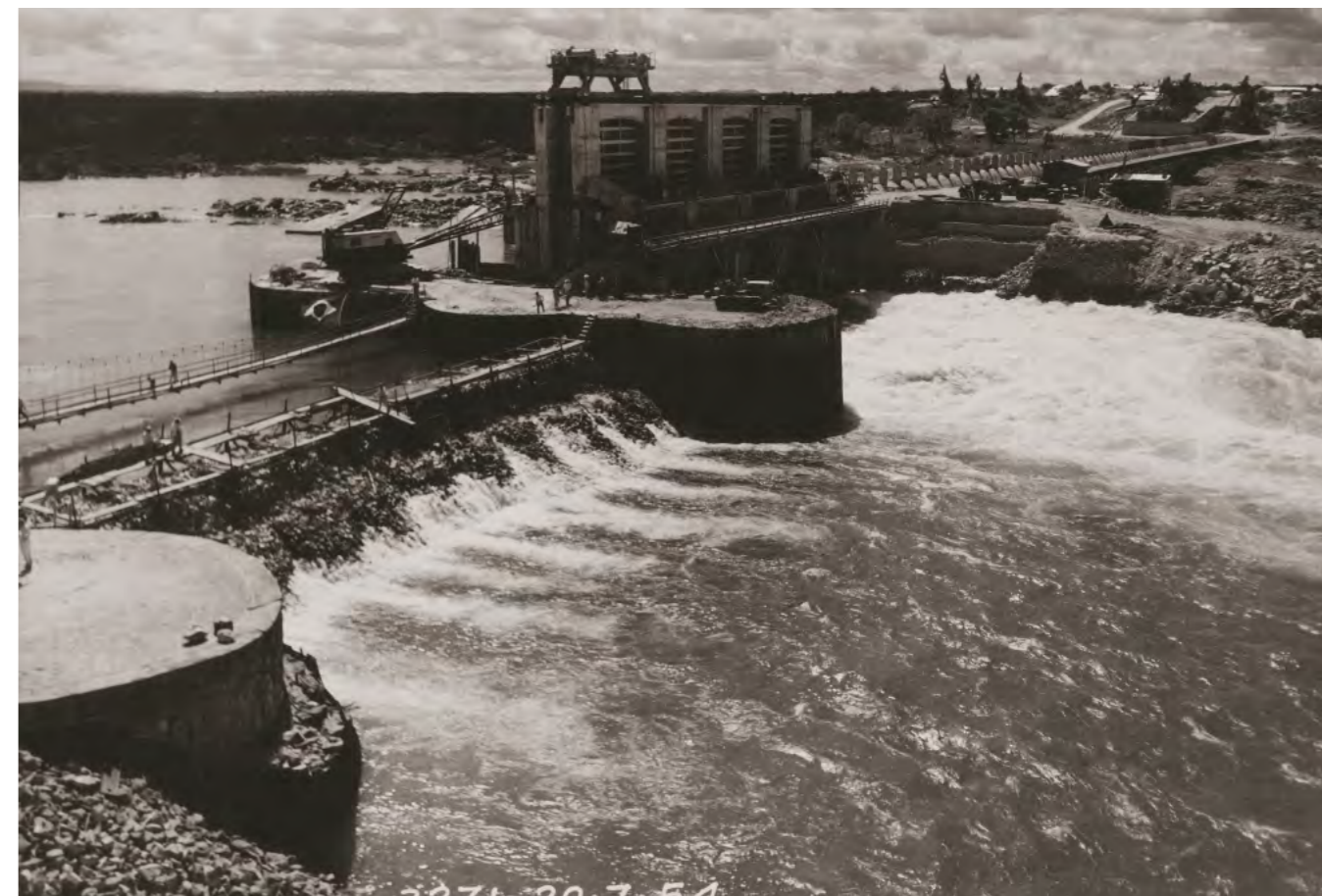
Fig. 15. Construção Usina Hidrelétrica de Paulo Afonso I. Foto: Memorial da eletricidade
