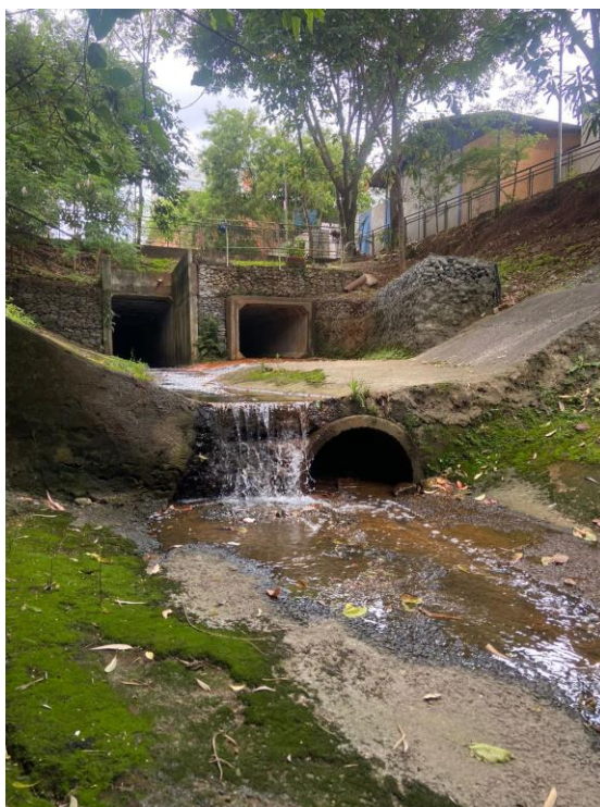
Figura 41 - estrutura de canalização do Córrego da Invernada
