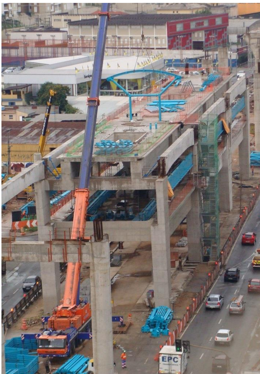
Figura 32 - Instalação dos primeiros elementos metálicos da cobertura
