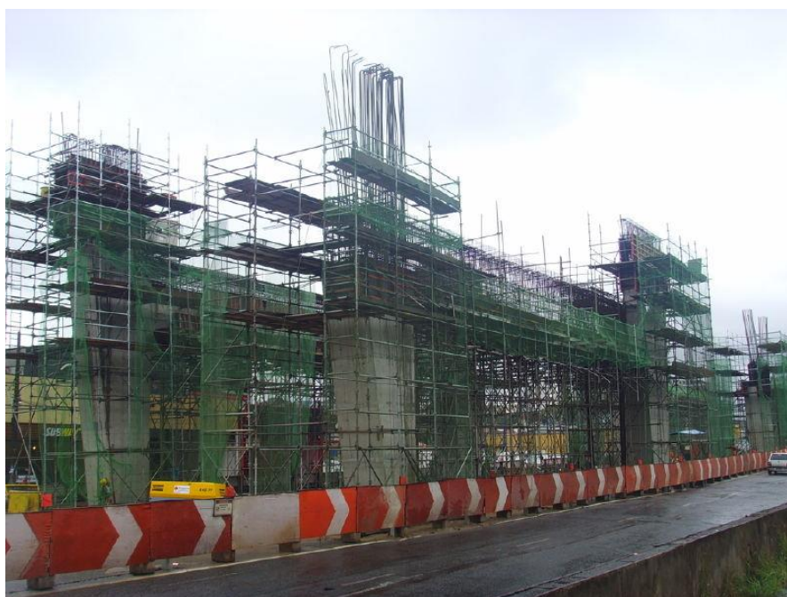
Figura 31 - Execução dos pilares da estrutura
