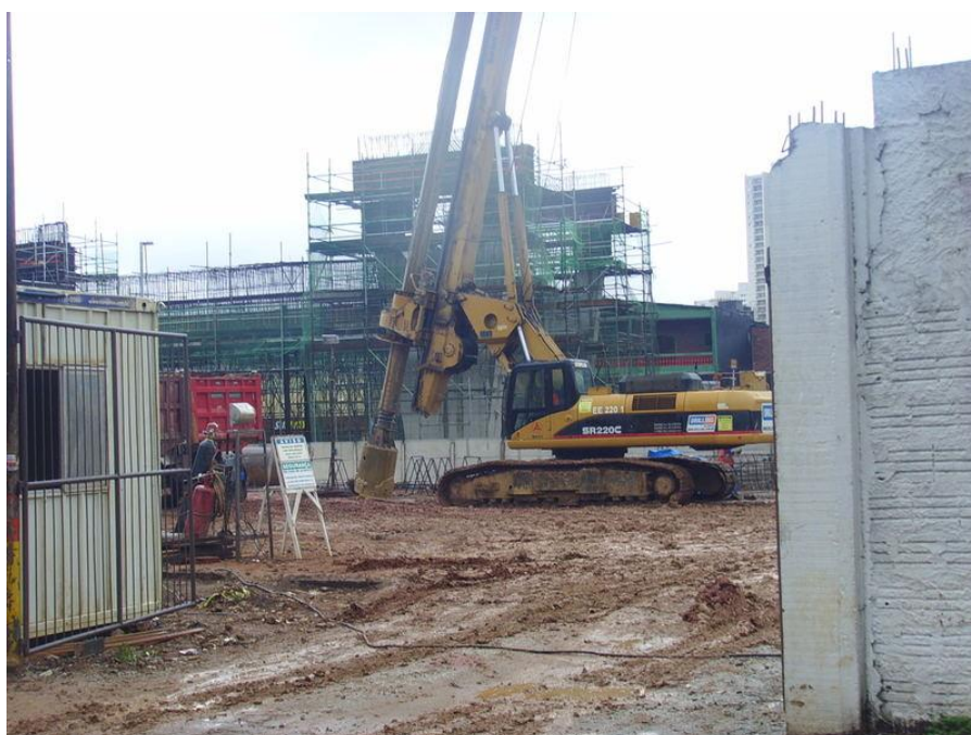
Figura 30 - Perfuratriz para execução do estação
