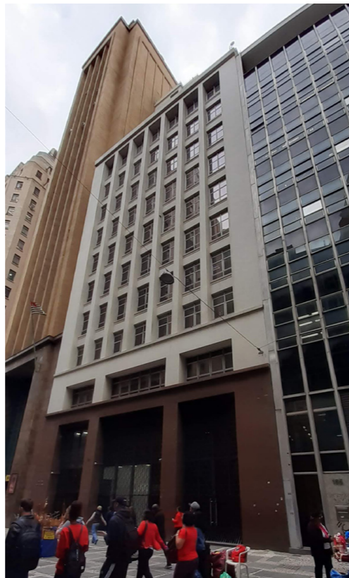
Edifício Rua 15 de Novembro, 137. Foto de autoria própria tirada em 03 de março de 2019.
