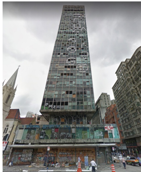
Edifício Wilton Paes de Almeida, na Av. Rio Branco, 10. Vista do Google Street View em 2014.
