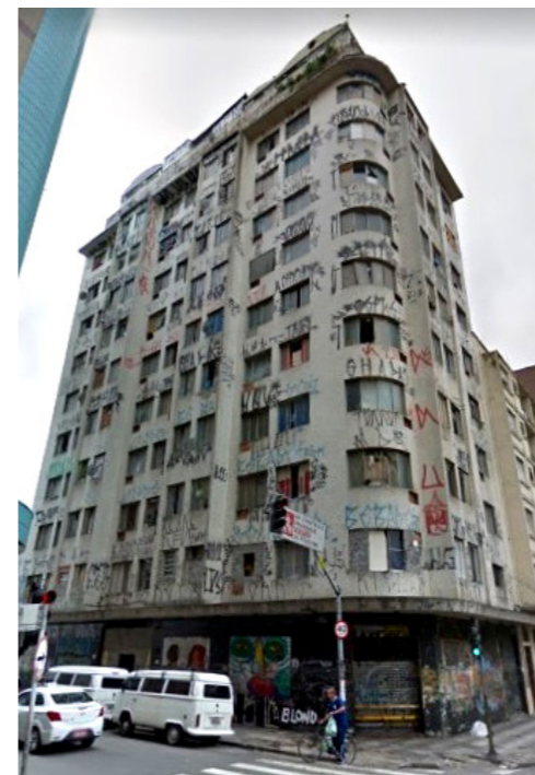
Edifício ocupado na Rua Conselheiro Nébias, 314. Imagem do Google Street View de 2017.
