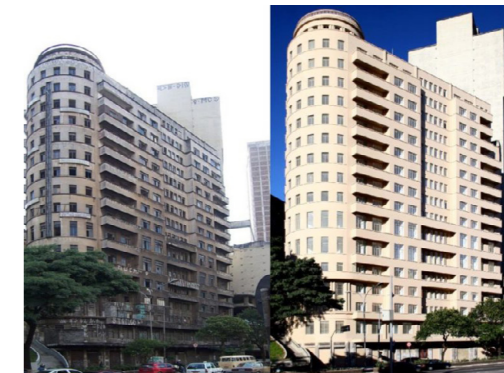
Comparativo do edifício Riachuelo antes e depois de ser reformado. Fonte: < https://www.caurj.gov.br/centro-de-sp-tem-exemplos-de-recuperacao-de-areas-como-saida-para-falta-de-moradia/riachuelo_0011-768x577/ >. Acesso em 03 de fevereiro de 2019.
