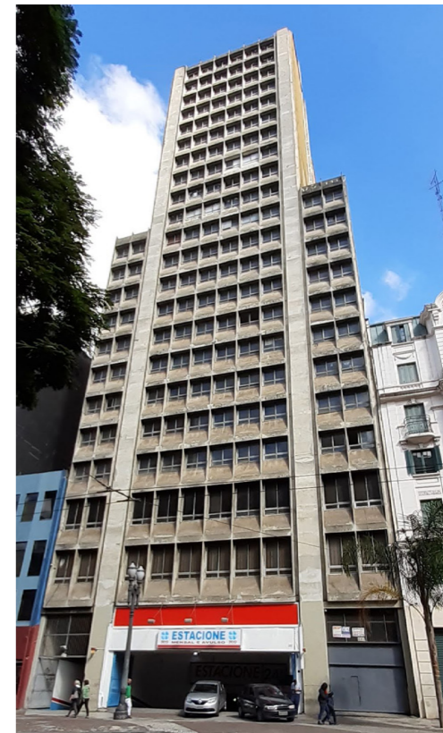
Edifício na Av. São João, 587. Foto de autoria própria tirada em 03 de março de 2019.
