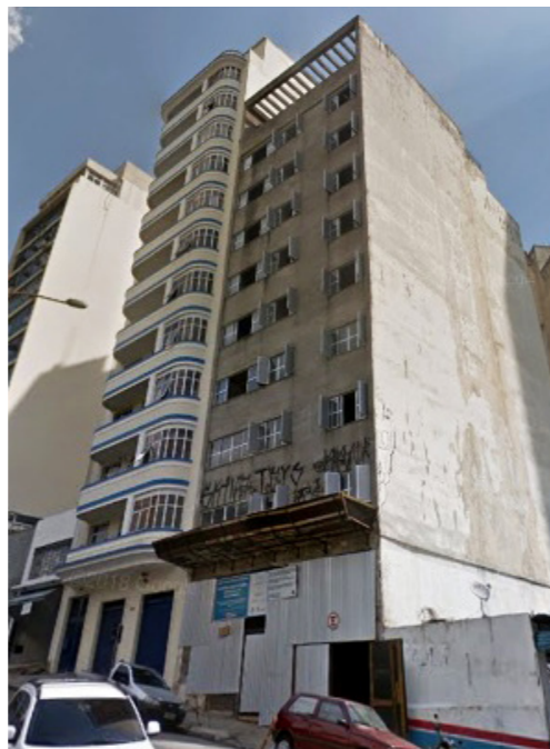
Edifício Asdrúbal do Nascimento, na Rua Asdrúbal do Nascimento, 282 (à esquerda). Imagem do Google Street View de 2017
