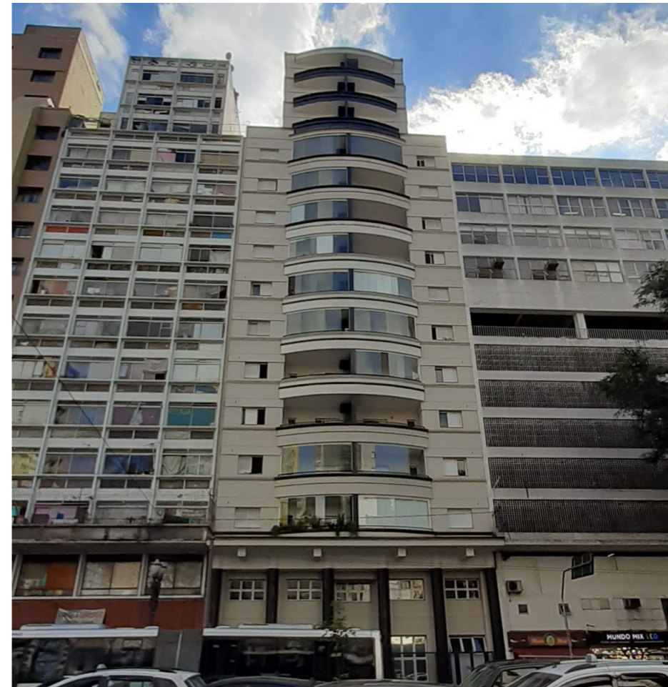
Edifício Europa Palace Hotel, na Av. Ipiranga, 895. Foto de autoria própria tirada em 23 de fevereiro de 2019.
