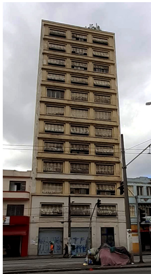
Edifício na Av. Mercúrio, 568. Exemplo de edifícios com testada entre 8 e 15 metros. Foto de autoria própria tirada em 03 de março de 2019.
