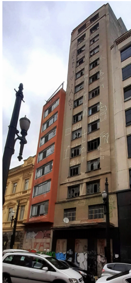
Edifícios na Rua Floriano Peixoto, 40-44. Foto de autoria própria tirada em 03 de março de 2019.
