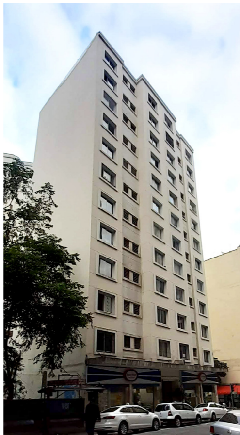
Edifício na Rua João Adolfo, 75. Exemplo de edifício com testada maior que 15 metros. Foto de autoria própria tirada em 03 de março de 2019.
