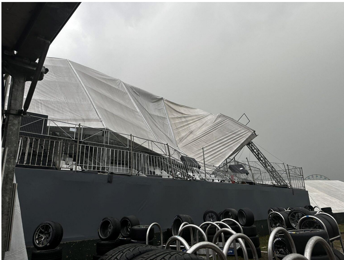
Figura 29 – Estrutura de arquibancada que cedeu com a forte chuva. Fonte: Andy Hone/Twitter
