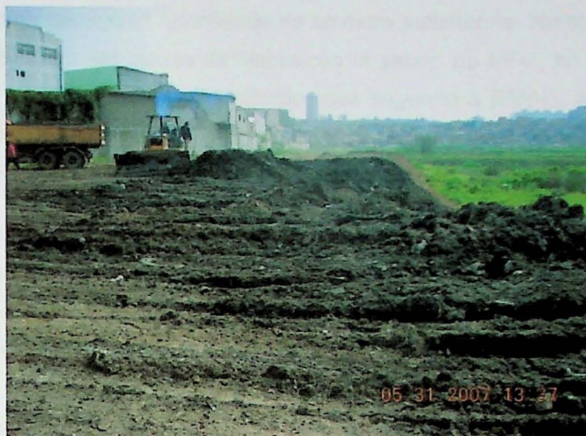
Figura 6 - Recebimento de sedimentos de dragagem no BF-Interlagos.
