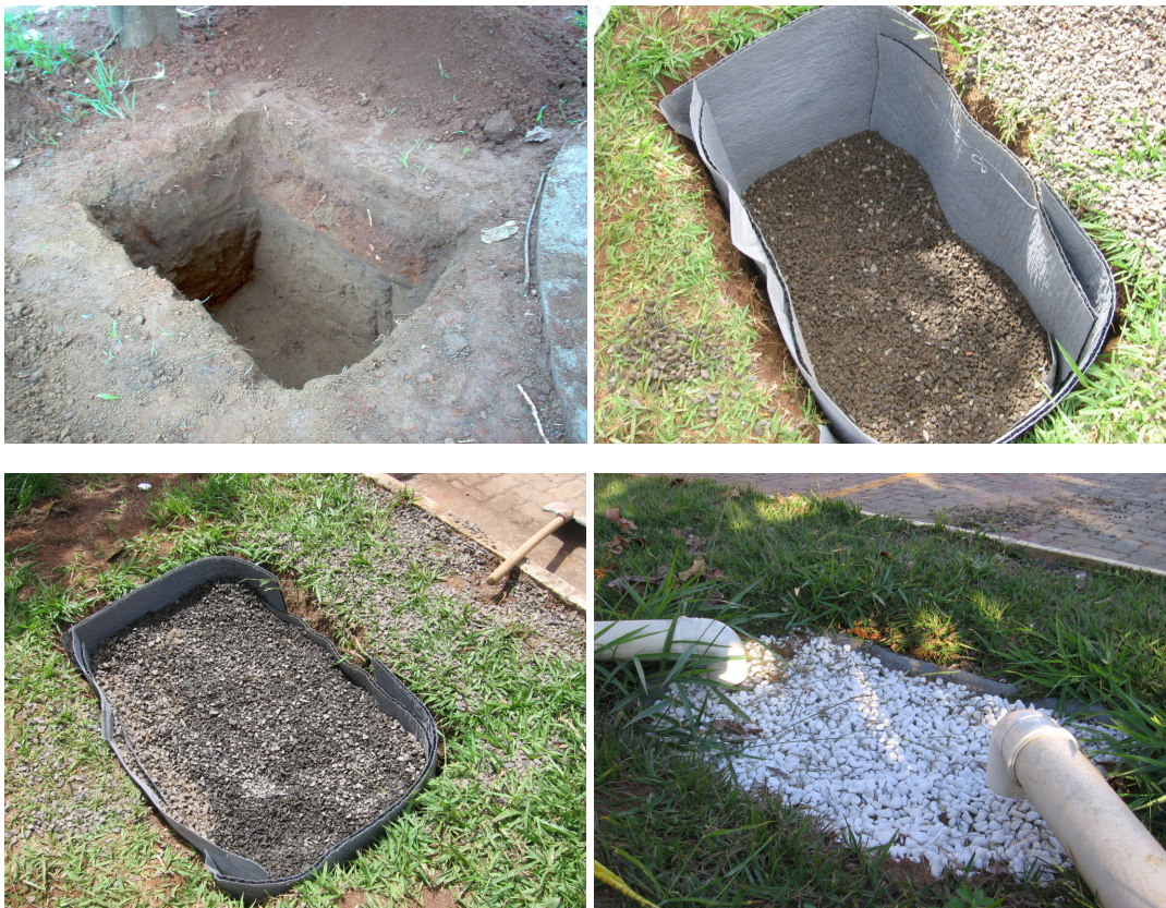
Figura 10. Etapas de construção da trincheira.
