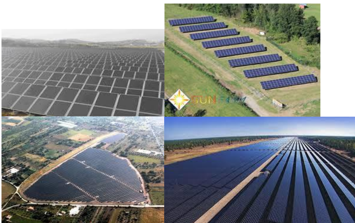
Figura 20- Exemplo de usinas solares fotovoltaicas UFVs tipo fazenda solares montadas sobre solo (ground mounted)
