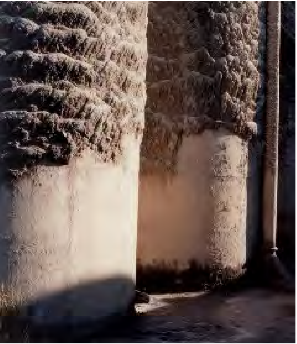
Imagem 24: Crosta de particulados nas superfícies externas de silos de cru. Arquivo de documentação da CONPRES, 1992.
