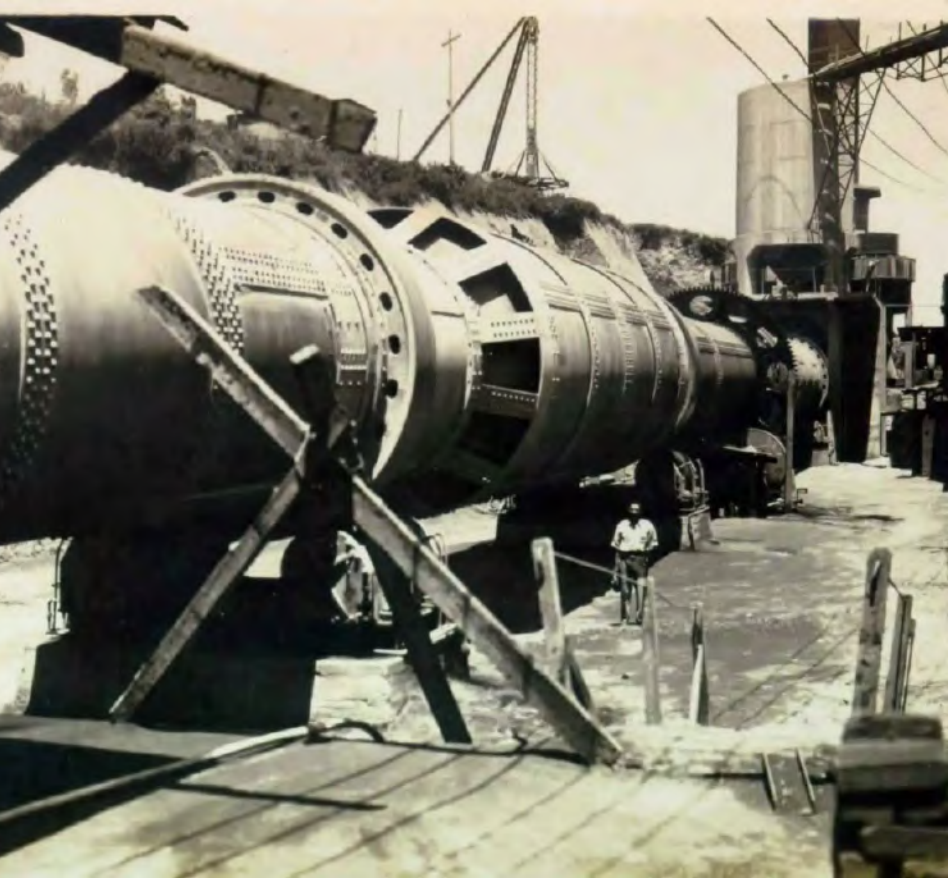
Imagem 15: Forno de calcinação 3 e, ao fundo, a recâmara. Fotografia feita nos primeiros anos de operação da fábrica, quando não havia ainda uma cobertura sobre o salão de fornos. Acervo de Nelson Camargo.
