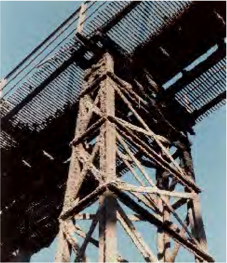
Imagem 23: Crosta de particulados nas estruturas metálicas de esteiras elevadas. Arquivo de documentação da CONPRES, 1992.
