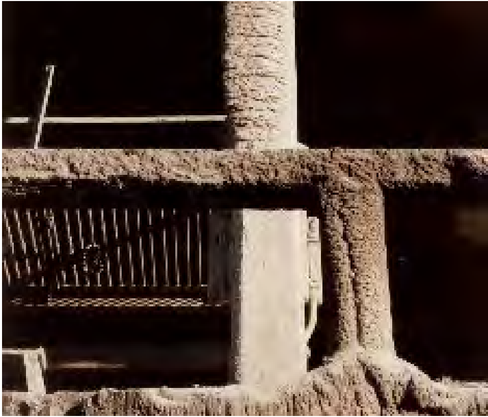
Imagem 22: Crosta de particulados de cimento em guarda-corpos e pilares. Arquivo de documentação da CONPRES, 1992.
