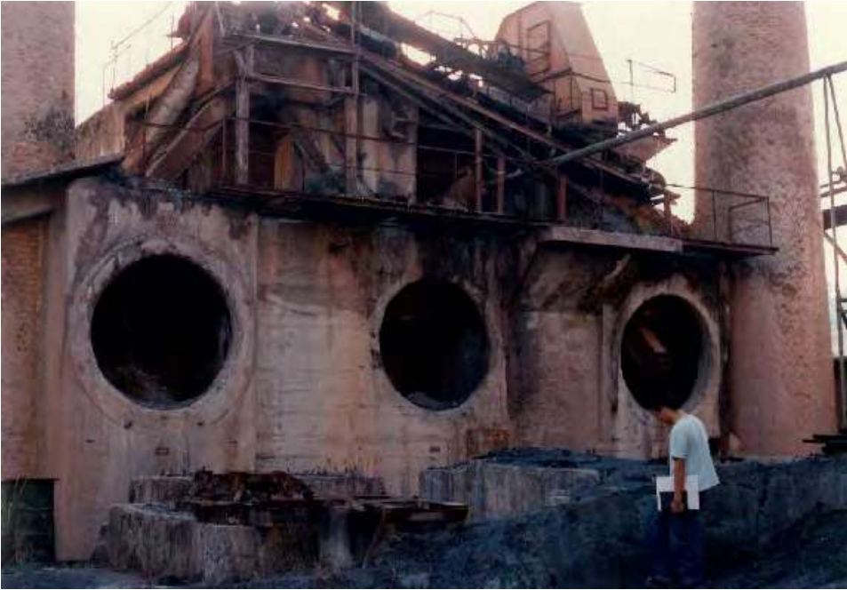
Imagem 11: Fotografia da recâmara adjacente ao depósito coberto. Nos orifícios circulares ficavam embocados cada um dos três secadores, e as chaminés ao lado faziam a exaustão do ar quente retido ali dentro. Fotografia realizada pela CONPRES P no ato de documentação para tombamento da fábrica em 1989.
