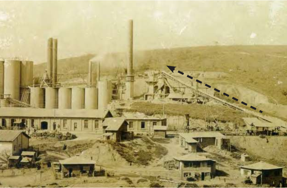
Imagem 7: Fragmento de fotografia onde é possível vislumbrar a estrutura de correias (tracejado meu) que conectava a plataforma de descarga com a de depósitos a sul. Acervo de Nelson Camargo.
