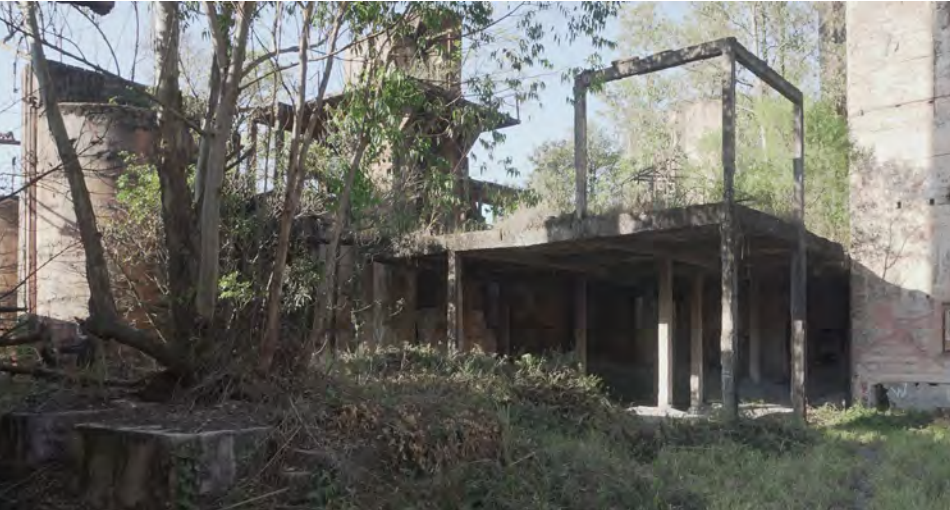
Imagem 12: Pátio coberto de mistura de matéria-prima e nos fundos, silos e torre de elevador. Fotografia feita por mim em 2023.
