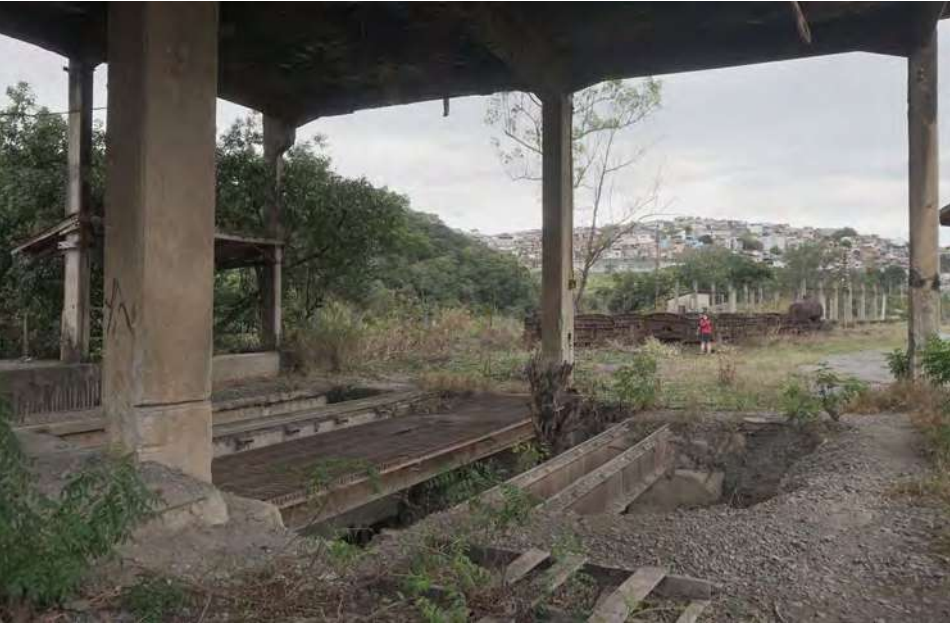
Imagem 6: Estação de descarga das vagonetas. Sob os trilhos há vãos e rampas por onde material rolava até os britadores em cota inferior. Fotografia feita por mim em 2023.
