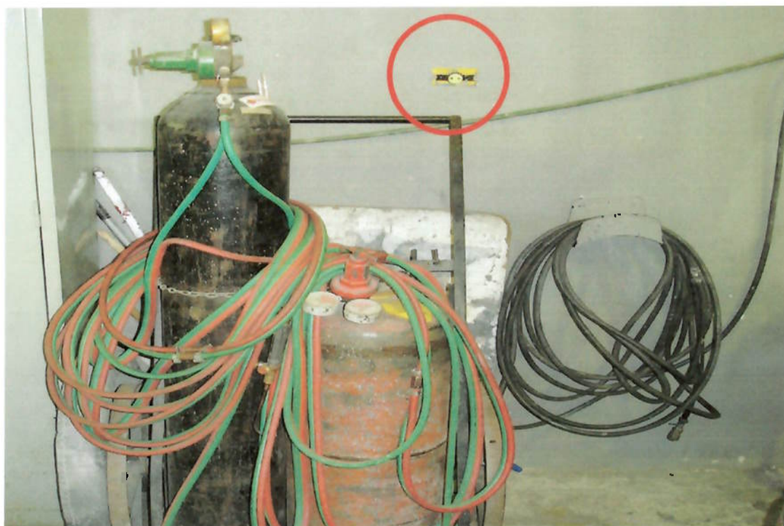
Foto 1 – Conjunto oxiacetilênico próximo a uma tomada comum.
