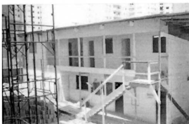
Figura 5: Exemplo de sistema racionalizado de módulos de chapa de compensado.
