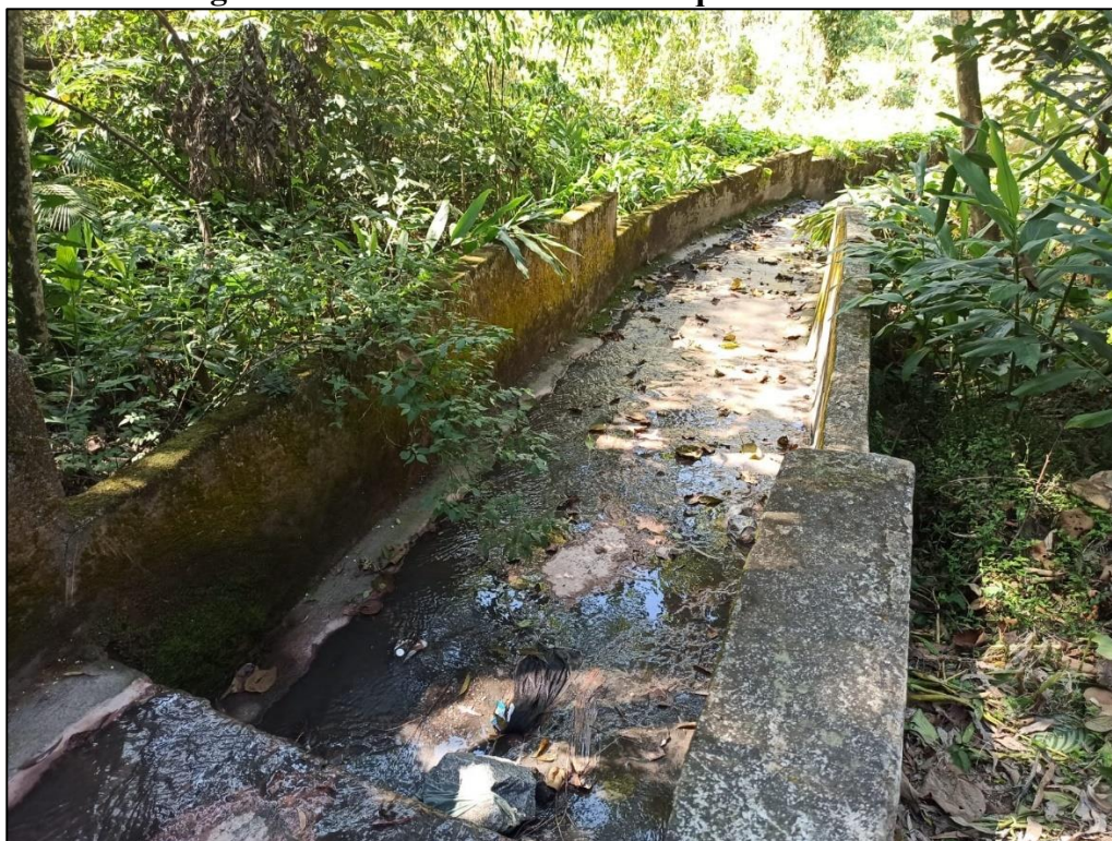
Fig. 10 - Escada hidráulica no Parque M'Boi Mirim
