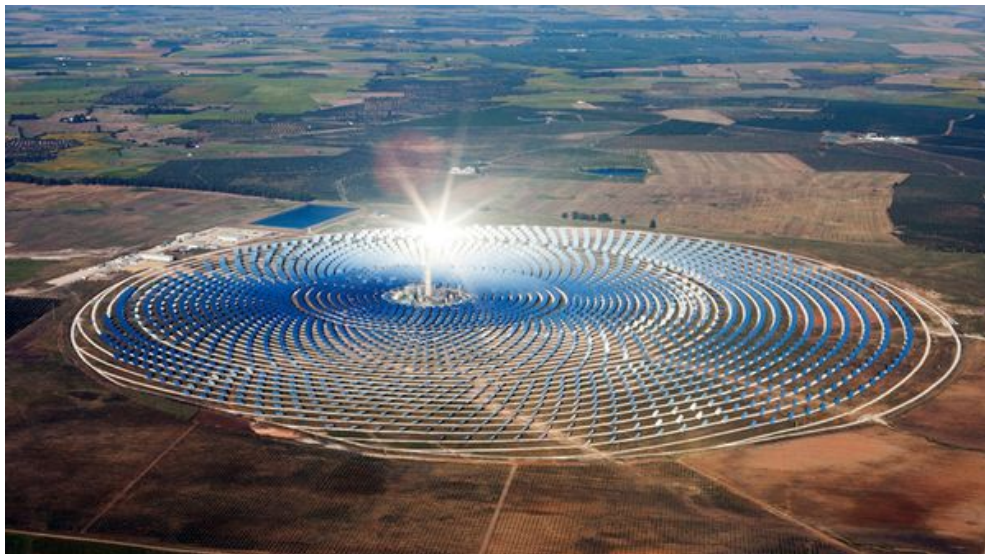
Figura 1.0 - Central de Torre Gemasolar da Torresol Energy em Sevilha na Espanha, 2011
