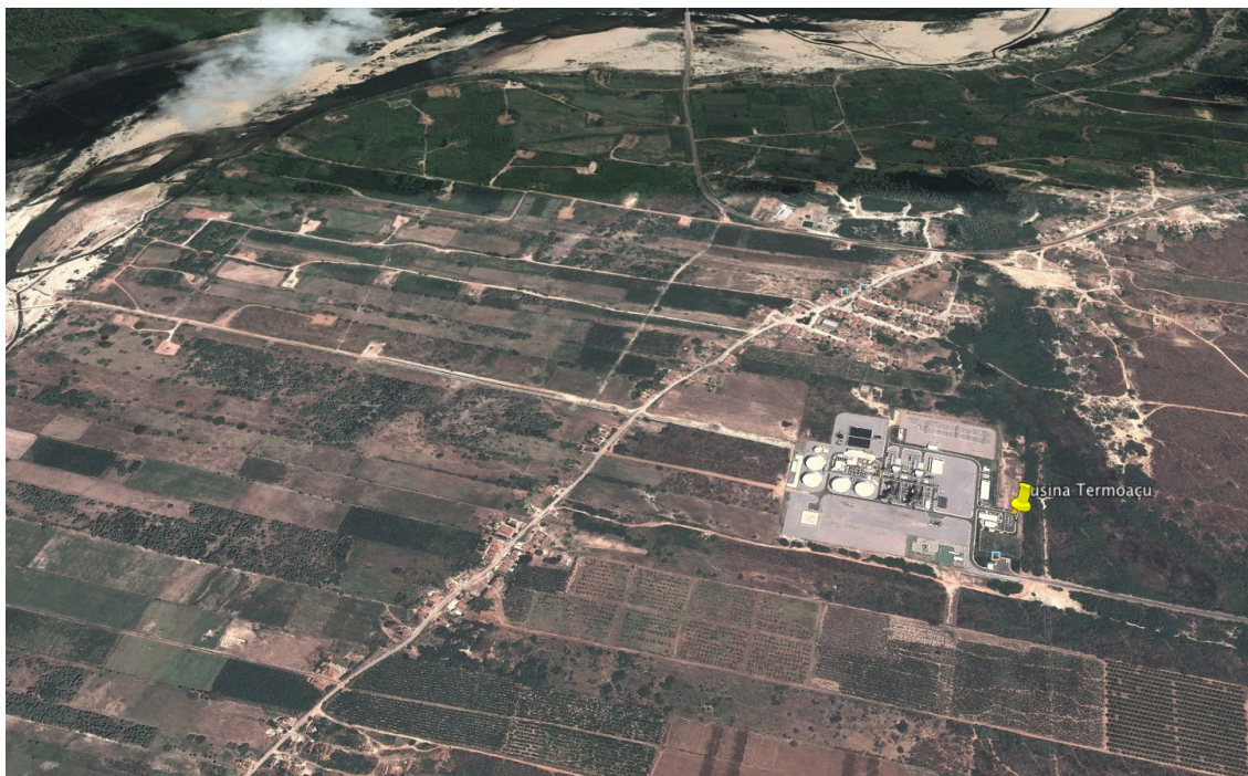
Figura 3.6 - Usina Jesus Soares Pereira / Termoaçu. Vale do Açu, Rio Grande do Norte
