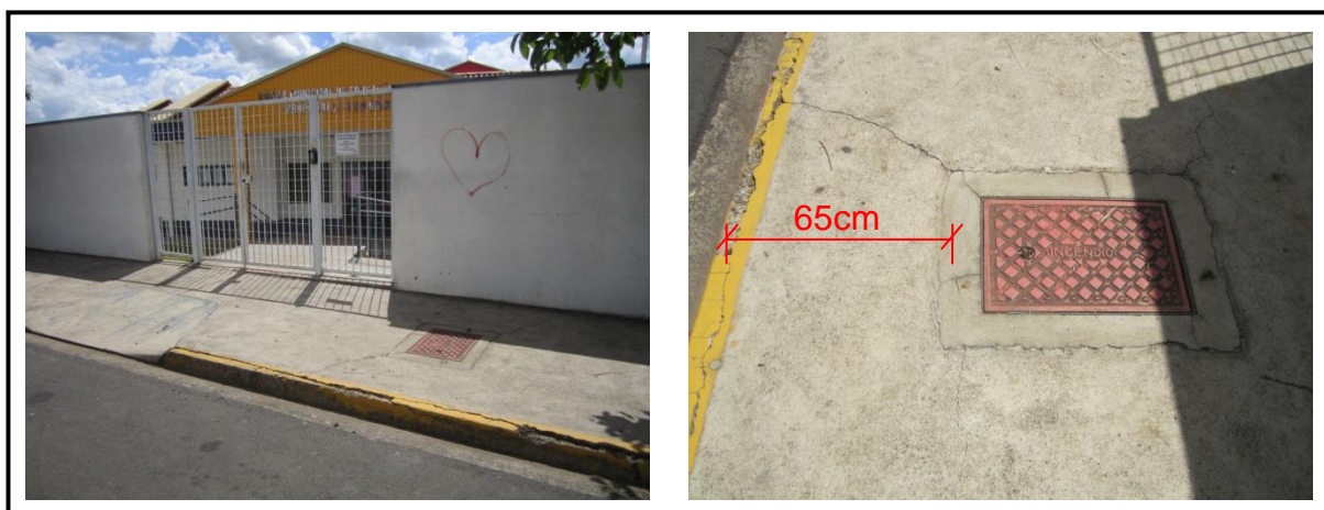
Figura 39 – Fachada da edificação e dispositivo de recalque.
