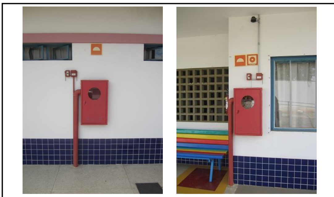
Figura 27 – Acionadores manuais de alarme e de bomba de incêndio.
