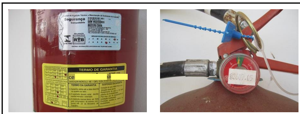
Figura 37 – Detalhe do selo do Inmetro, garantia da inspeção e o indicador de pressão do extintor.
