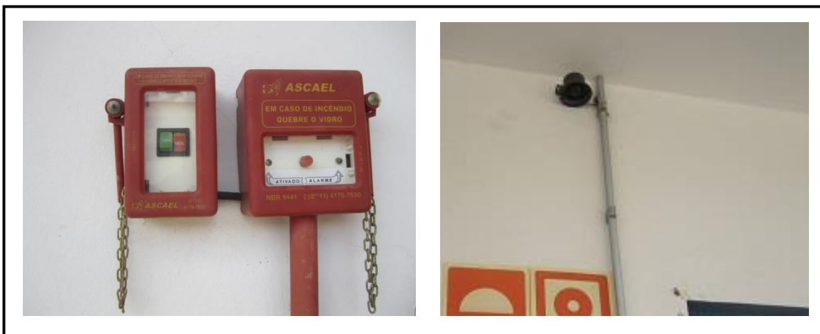
Figura 28 – Detalhe dos acionadores manuais da bomba e alarme de incêndio e do avisador sonoro.
