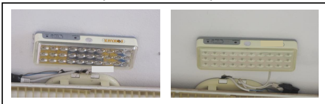
Figura 26 – Luminárias de emergência.
