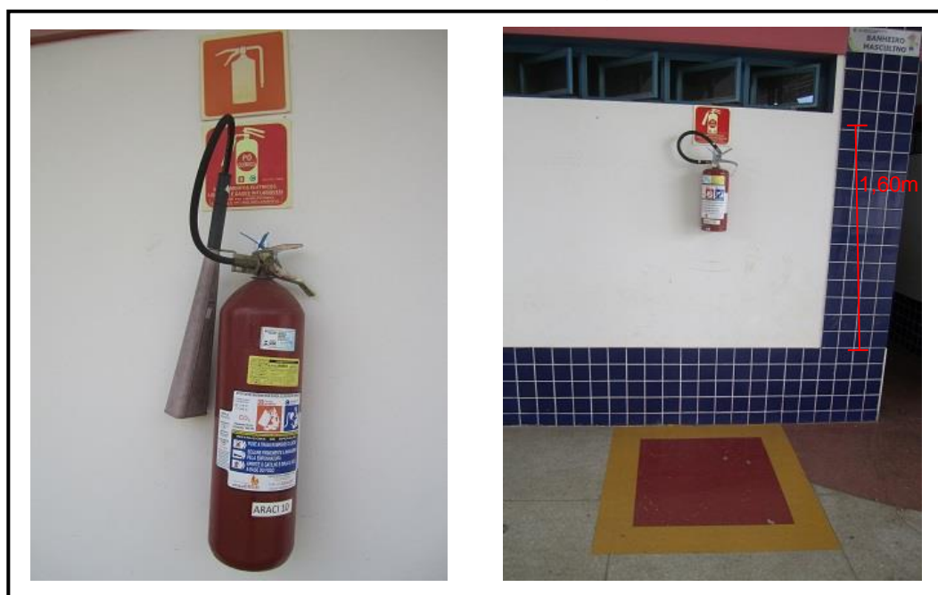
Figura 32 – Não conformidades na sinalização dos extintores.
