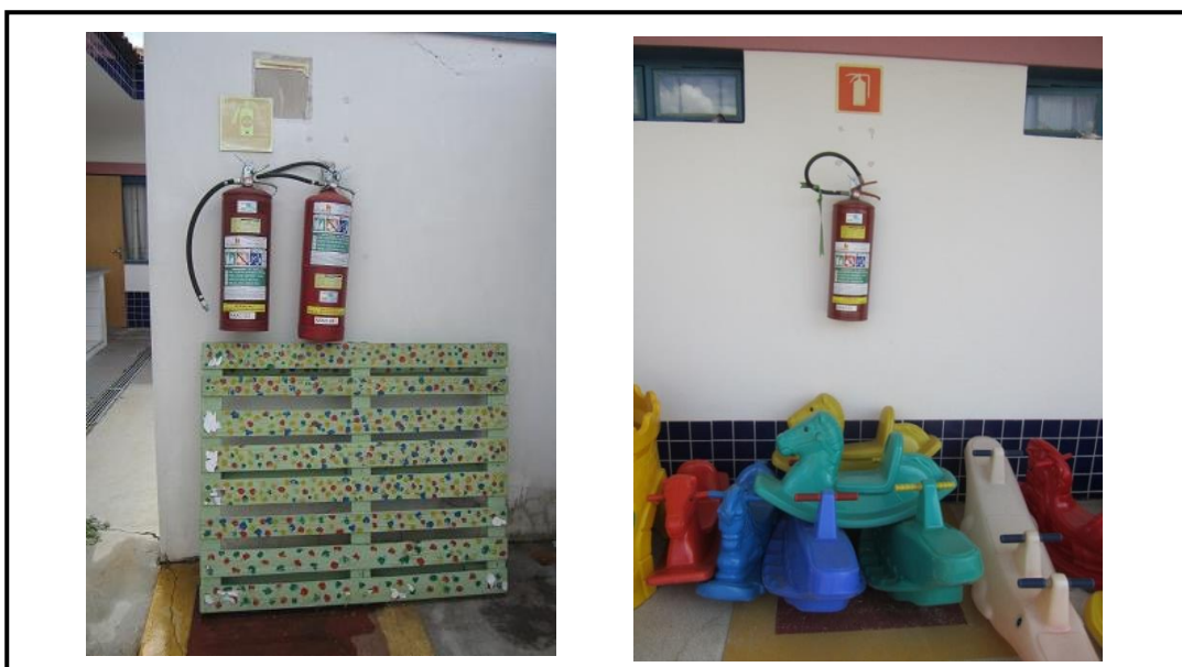
Figura 33 – Não conformidades na sinalização dos extintores.
