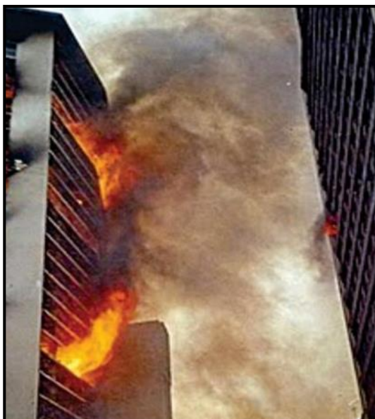
Figura 3- Propagação do incêndio por convecção.
