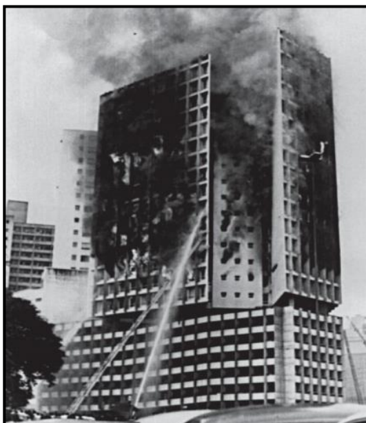
Figura 2- Propagação do incêndio por condução.
