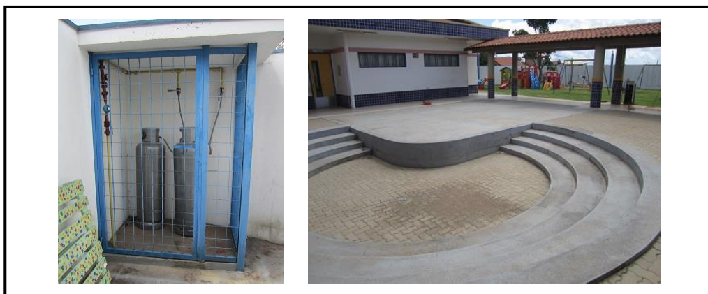
Figura 34 – Ausência de sinalização de proibição e alerta.
