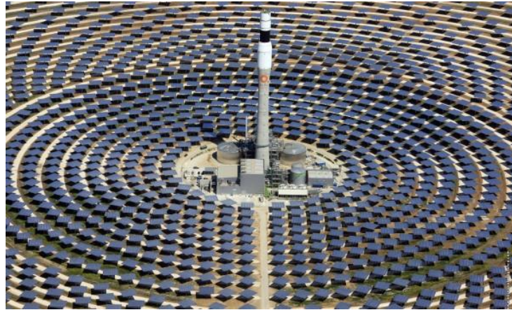
Figura 8 - Torre solar - fonte: https://www.diariorenovables.com/2017/09/dubai-precio-termsolar-bajo-central-mas-grande-mundo.html
