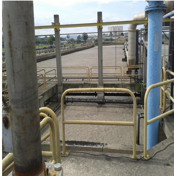
Figura A. 3 Tanque de Aeração
