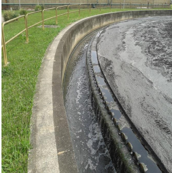
Figura A. 9 Decantador Secundário
