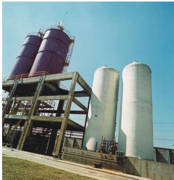
Figura 14 - À esquerda silos de armazenamento de cal (lilás).
