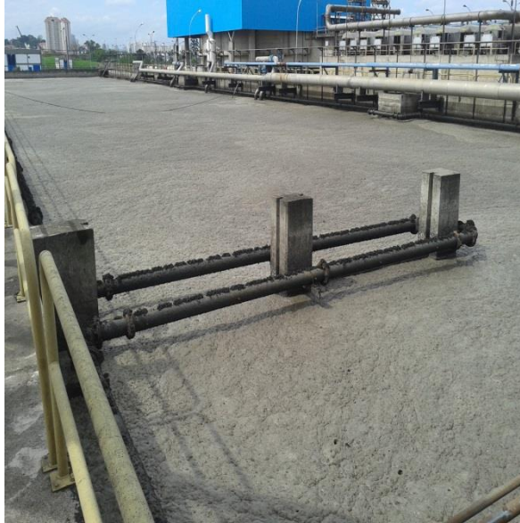
Figura A. 5 Tanque de Aeração
