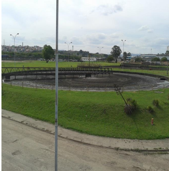
Figura A. 7 Decantador Secundário
