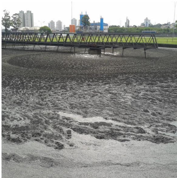
Figura A. 7 Decantador Secundário
