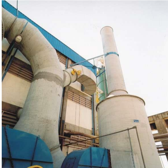
Figura 15 - Sistema de Lavagem dos Gases coletados no prédio de desidratação de lodo.
