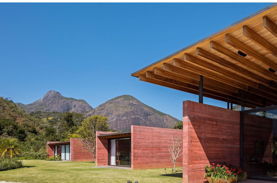
Muros de concreto pigmentado e estrutura de madeira da cobertura (Bernardes Arquitetura).
