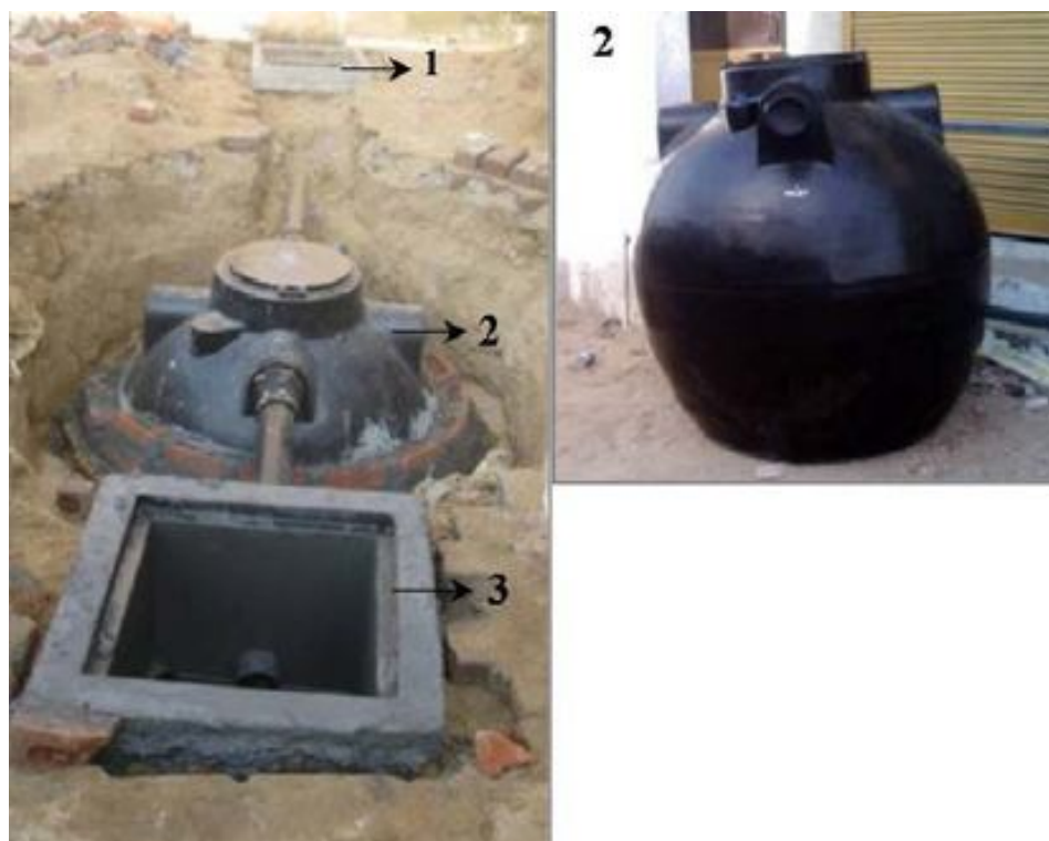
Figura 9 – Fotos representando o sistema bifásico de tratamento de esgoto, a esquerda é possível visualizar a caixa de entrada de esgoto (1), tanque séptico com filtro anaeróbio (2) e caixa de saída do esgoto (3). Já na direita visualiza-se somente a associação do tanque séptico com filtro anaeróbio.
