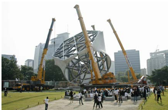
28 Guindastes erguendo e rotacionando o Prada Transformer, projetado pelo OMA, a fim de modificar a sua funcionalidade
