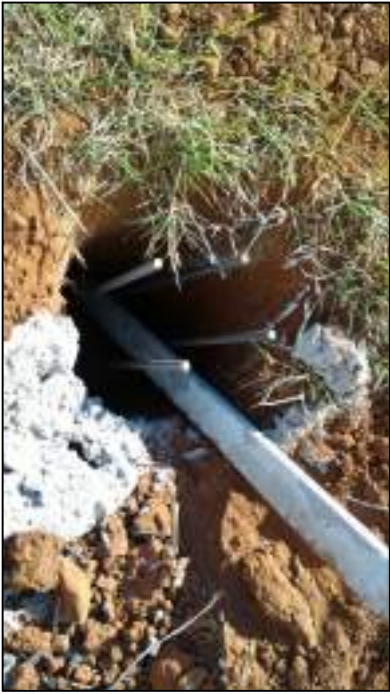
Exemplo de cota de arrasamento
