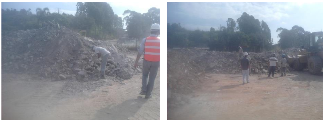
Figura 4-5 Triagem visual e manual anteriormente à britagem.
