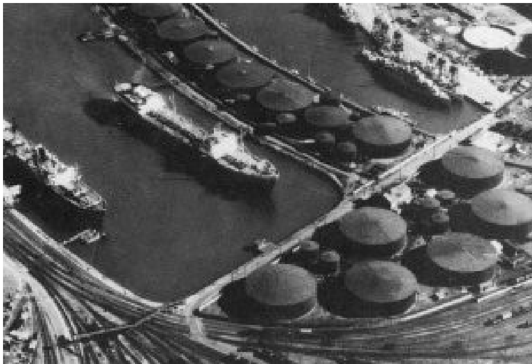
Figura 3 - Antigo Estuário Represado com os Tanques de Armazenamento
