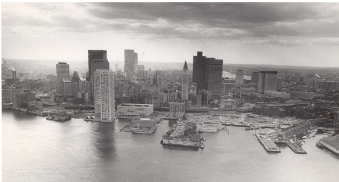
Figura 10 –Vista do Porto e do horizonte de Boston em 11 de dezembro de 1978
