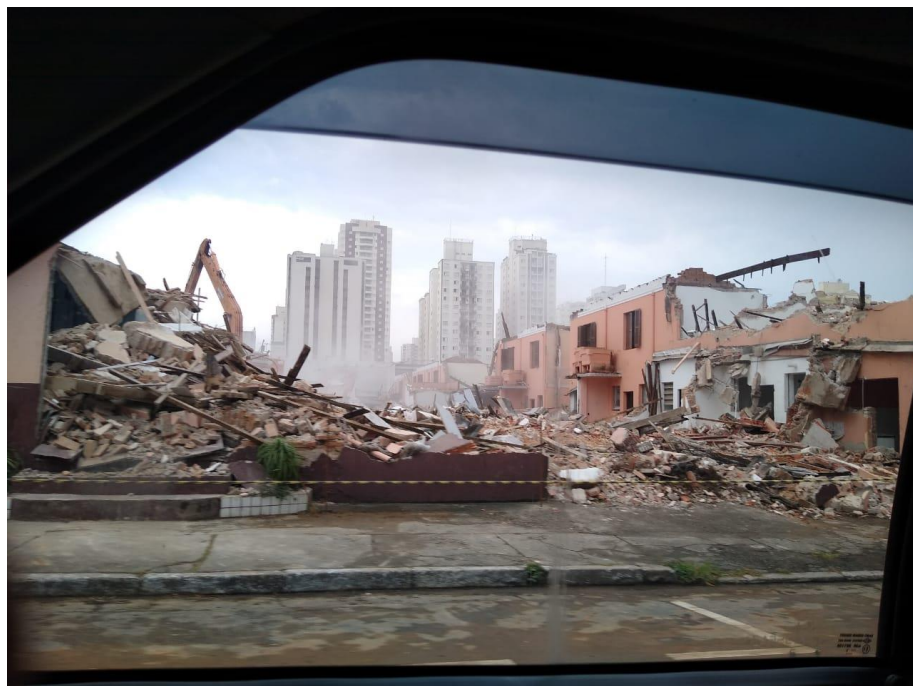
Figura 6 - Casas da Vila João Migliari sendo demolidas
