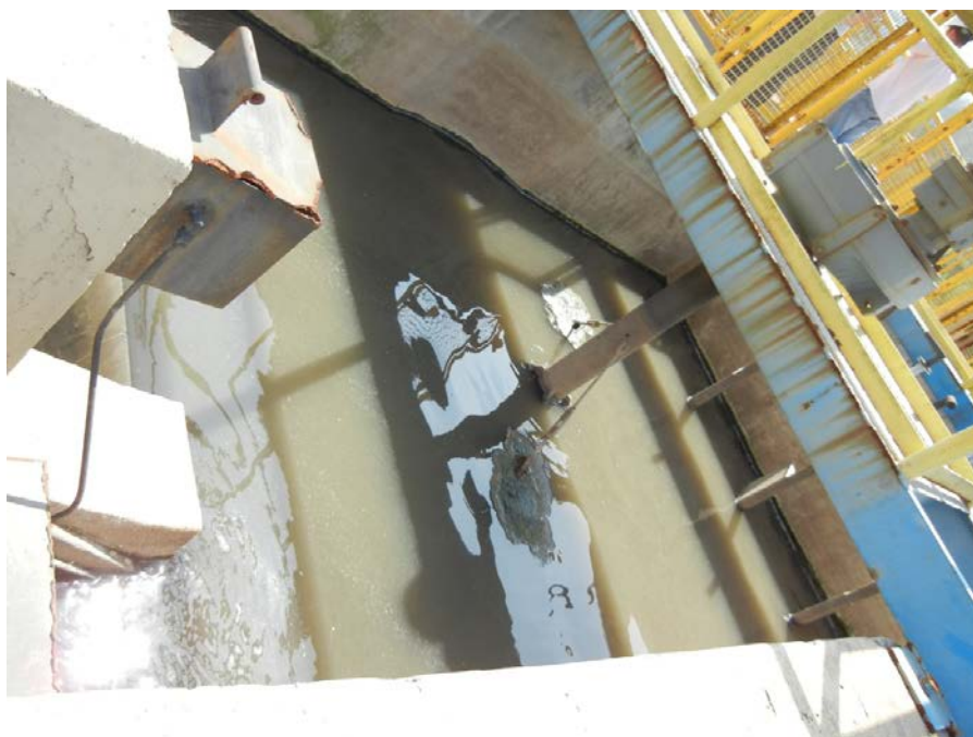
Figura 28: Caixa de areia com remoção mecanizada
