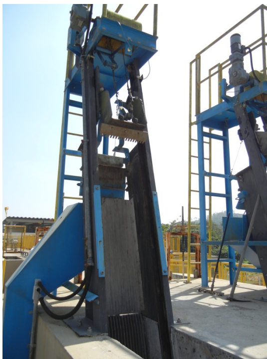
Figura 26: Gradeamento com limpeza mecanizada.
