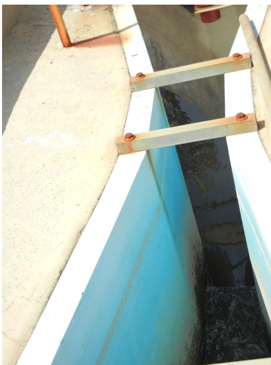
Figura 27: Calha Parshall para medição de vazão.
