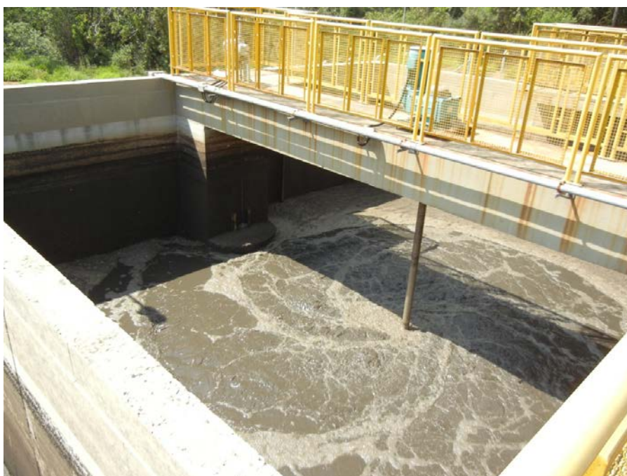
Figura 29: Reator / Decantador
