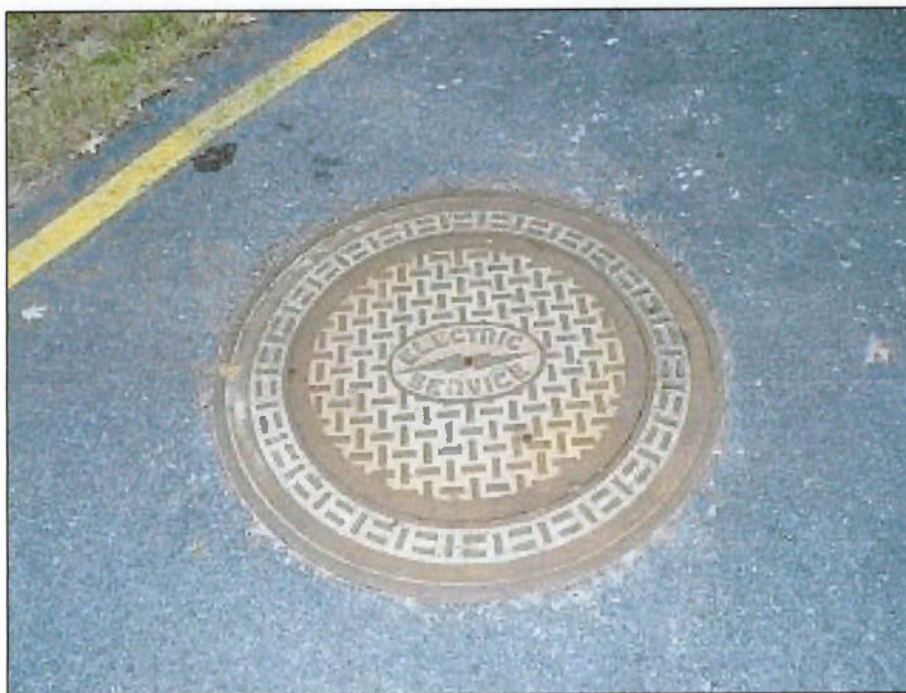
Foto 2 – Abertura de uma câmara subterrânea
