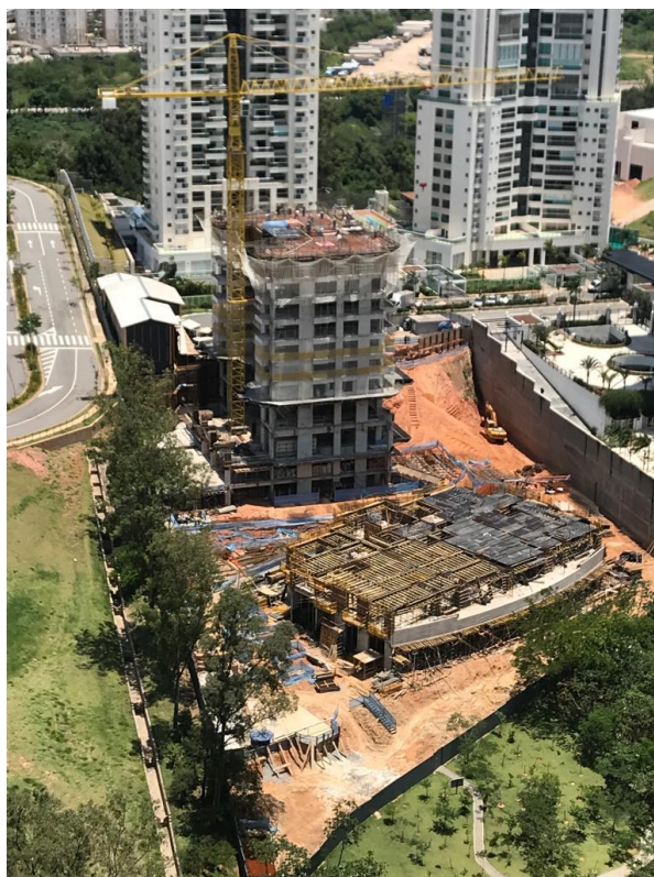
Figura 31: Produção dos blocos de fundação da torre “A” e da estrutura do pavimento térreo da torre “B”. Autor: Manuela Gomes.
