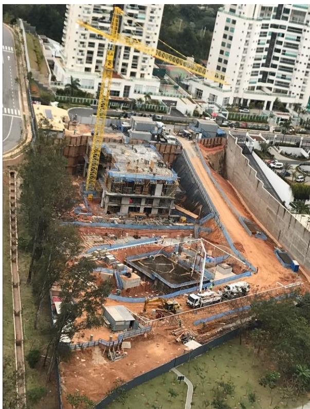
Figura 31: Produção dos blocos de fundação da torre “A” e da estrutura do pavimento térreo da torre “B”. Autor: Manuela Gomes.
