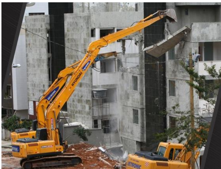
Figura 34 - Escavadeira realizando puxamento de alvenaria
