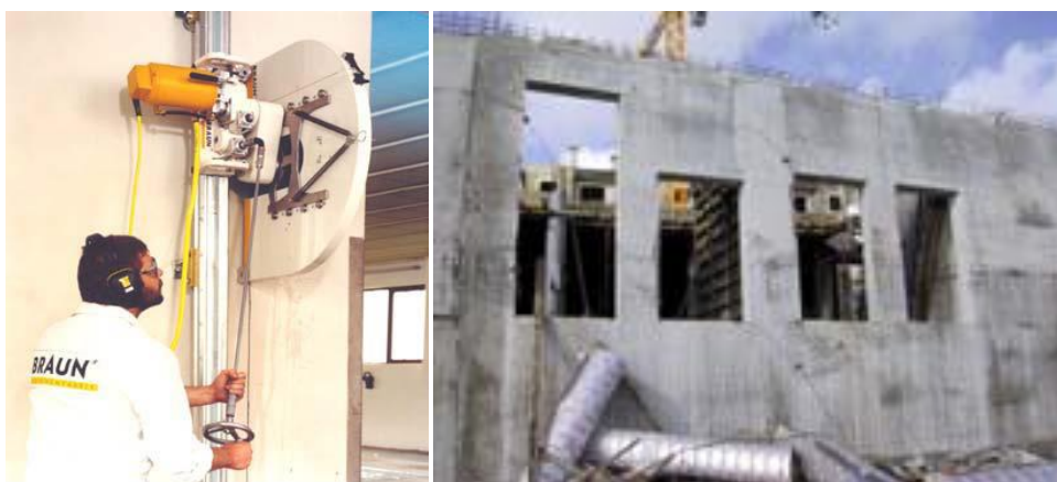
Figura 37 - Serra de parede (esq.) e aberturas de janelas em concreto feitas pelo material (dir.)
