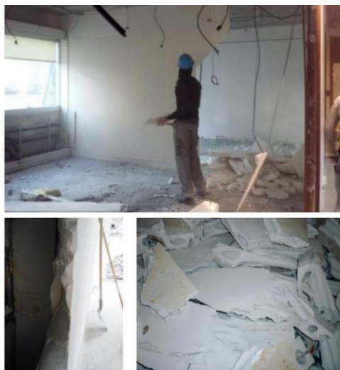
Figura 9 - Demolição com picareta da alvenaria de gesso (GtoG, 2015)
