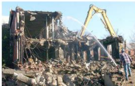
Figura 47 - Aspersão de água para controle de particulado
