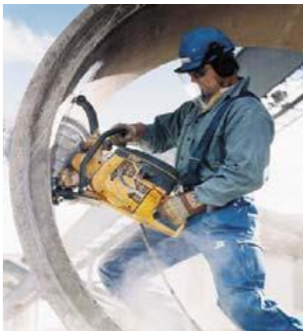
Figura 36 - Uso do disco portátil em estrutura única de concreto
