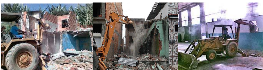
Figura 19 - Trabalhos de demolição por compressão com retroescavadeira
