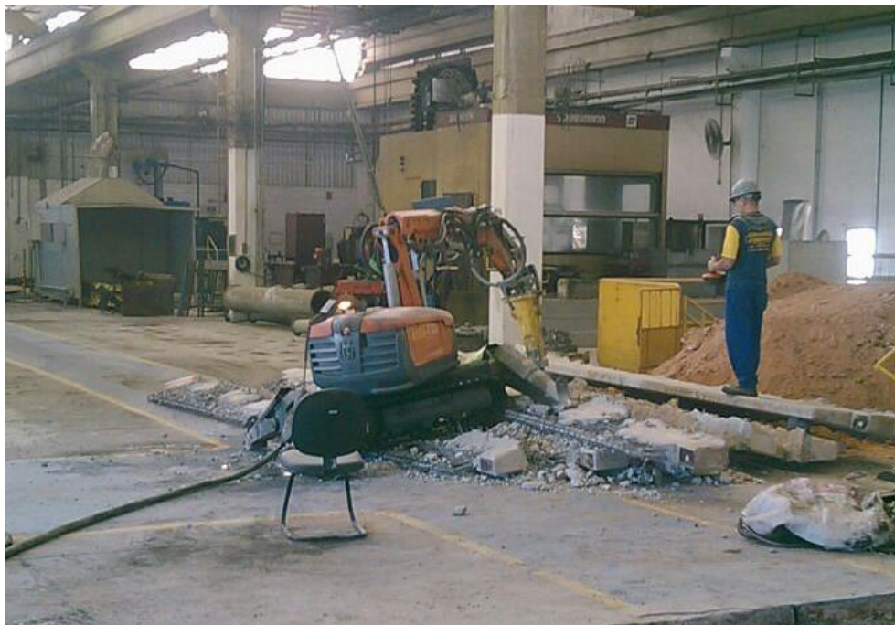
Figura 56 - Uso do robô de demolição para britagem do concreto armado
