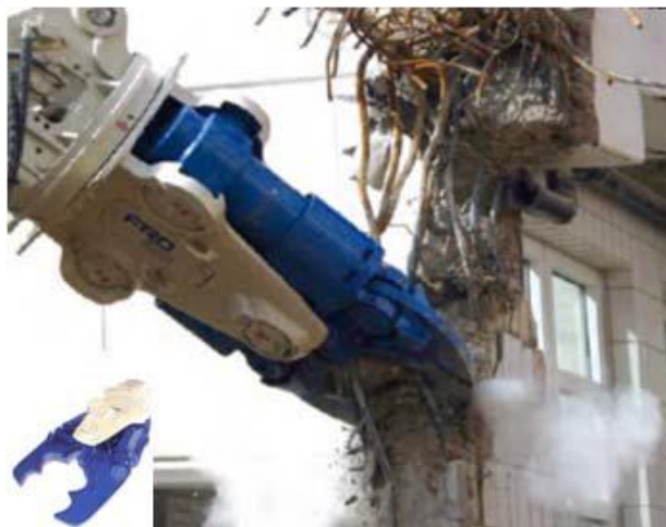
Figura 18 - Tesoura demolindo estrutura de concreto armado
