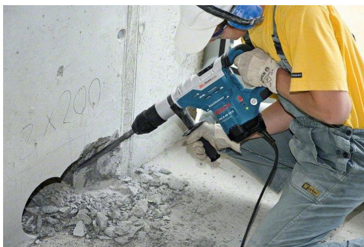
Figura 14 - Uso de martelo perfurador
