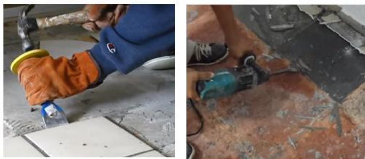
Figura 7 - Remoção de revestimento cerâmico
