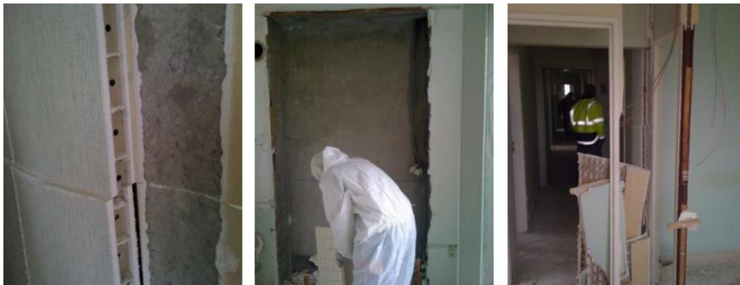
Figura 12 - Desconstrução por corte com serra
