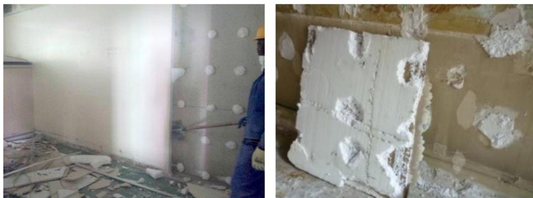
Figura 10 - Deslocamento com o uso de pá e placa retirada após o processo (GtoG, 2005)
