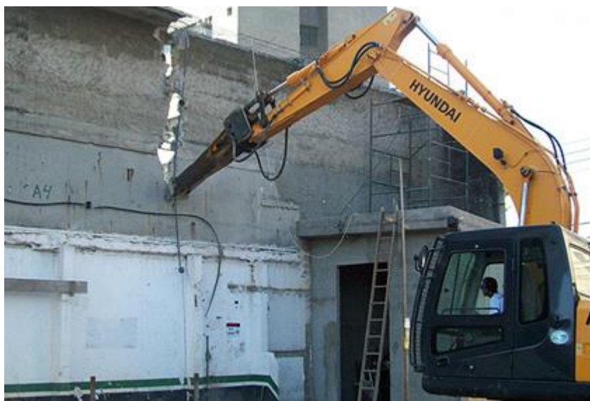
Figura 27 - Retroescavadeira com rompedor separando uma seção de parede
