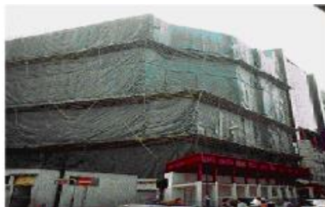
Figura 46 - Obra de demolição protegida por andaimes fachadeiros e telas (Hong Kong, 2006)
