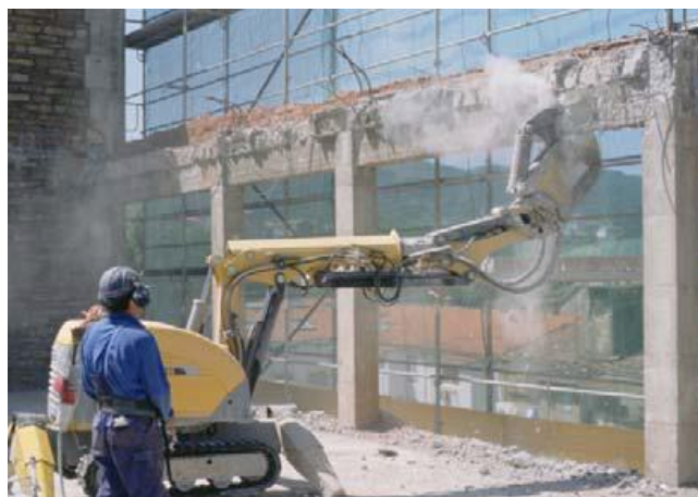
Figura 20 - robô de demolição com tesoura de corte
