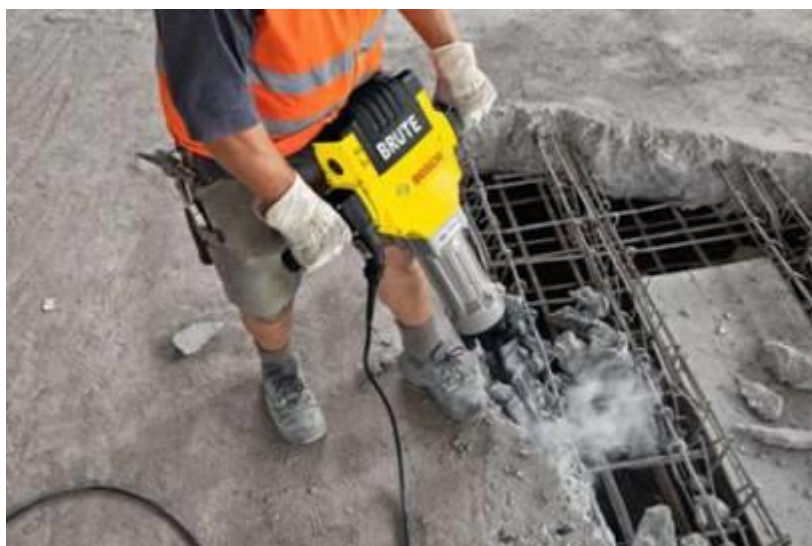
Figura 23 - Rompimento do concreto da laje
