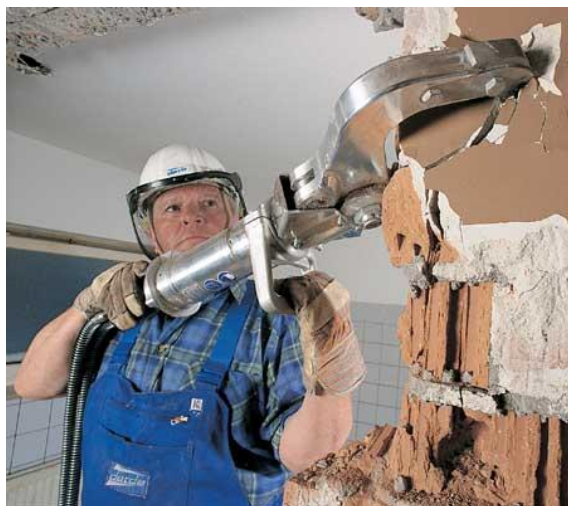
Figura 17- Demolição de parede de alvenaria com tesoura hidráulica
