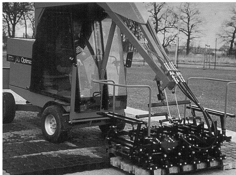
Figura 2 - Assentamento mecanizado de pavers – Alemanha (ABCP, 2001).
