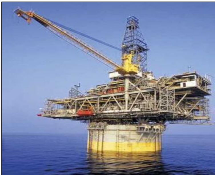
Figura 8 - Spar-buoy Mad Dog em operação no Golfo do Mexico
