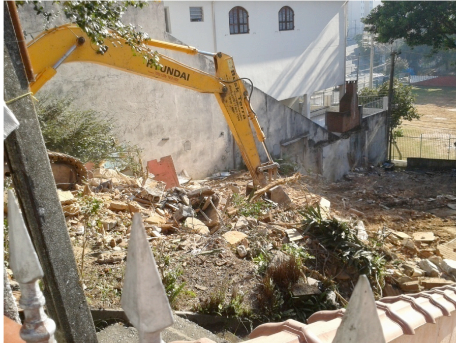
Figura 58: Demolição e limpeza do terreno
