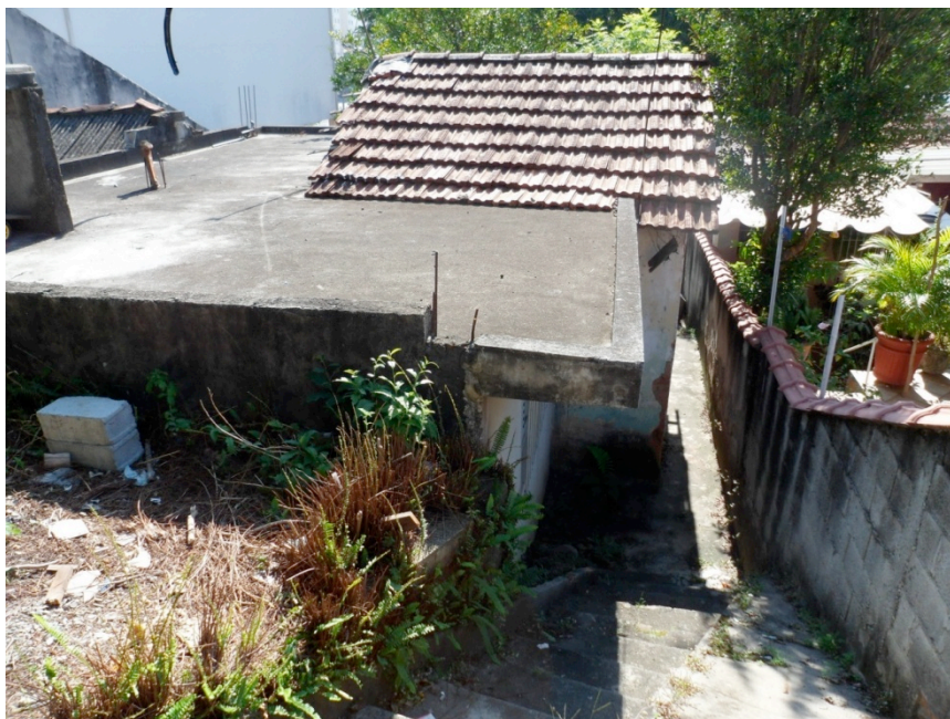
Figura 10: Construção existente com saída para a Rua Cláudio Manoel
