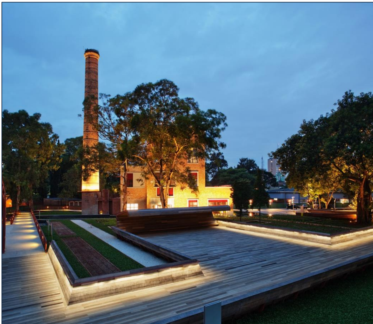
Figura 4: Praça Victor Civita, criada a partir do projeto de revitalização, que considerou a manutenção da edificação e chaminé do antigo incinerador. Fonte: Nelson Kon 3 .
