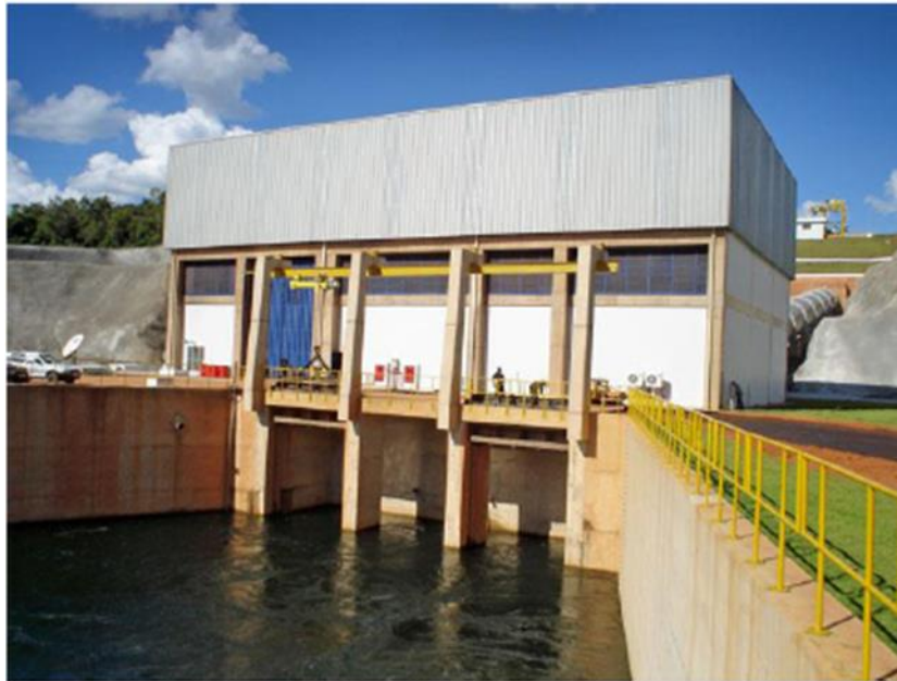
Figura 19 - Casa de Maquinas
