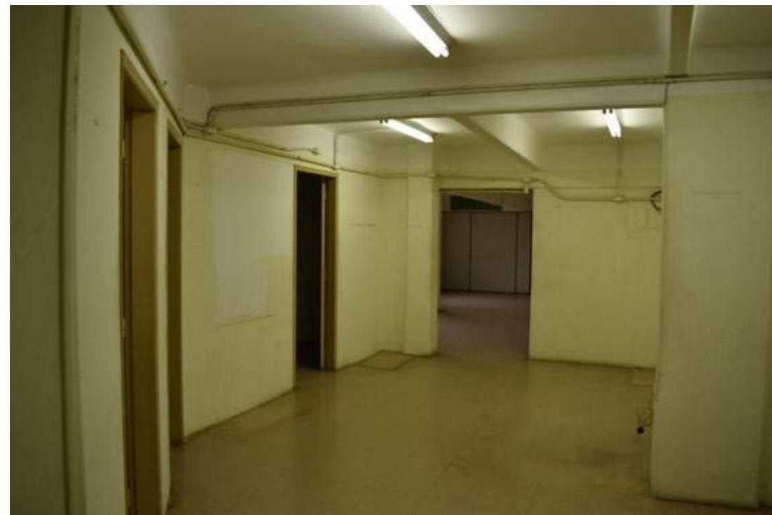
Figura 117 – Vista do corredor do 1º andar. Nota-se o acabamento curvo das vigas, bem como as divisórias de drywall aos fundos. Foto particular.
