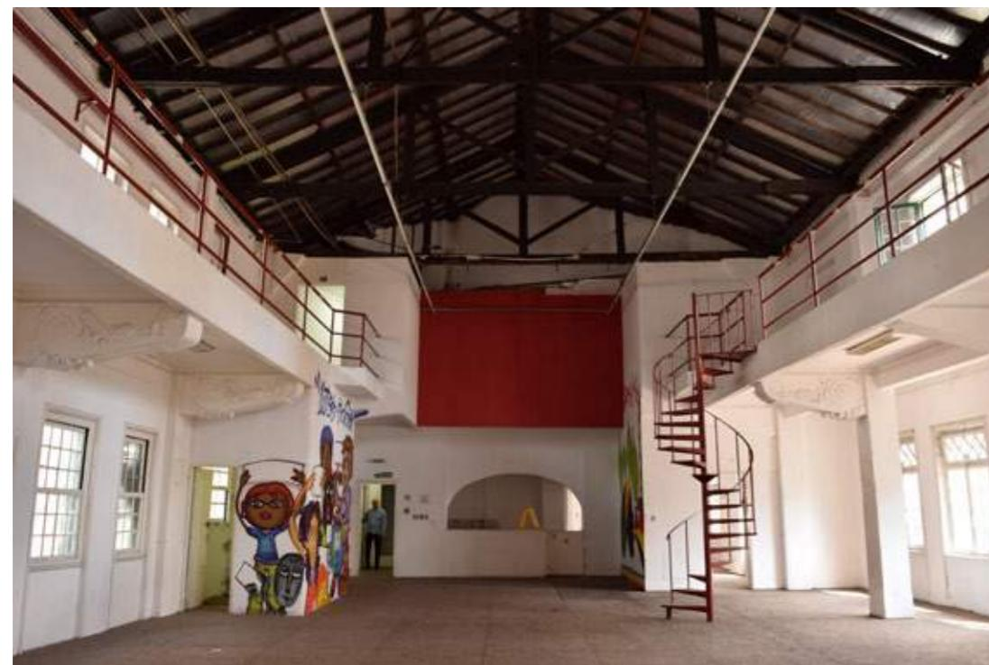
Figura 130 \_ Vista panorâmica da relação entre 4º e 5º andar. Nota-se a escada metálica no vão central, bem como as estruturas ornamentadas de sustentação do mezanino. Foto particular.
