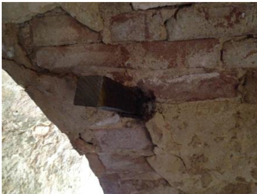
Figura 28: Origem da amostra 154. Estrutura de ferro do forno de Ipanema. A ponta de ferro ficou exposta no interior do forno após uma reforma realizada em 1866, para construção da cavilha entre os fornos.
