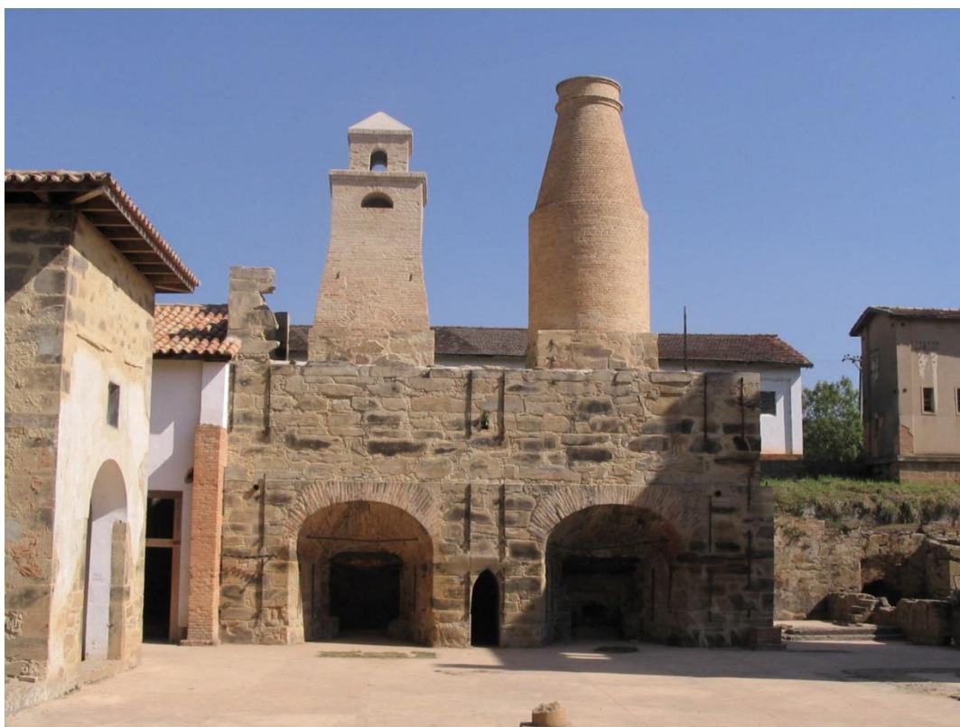
Figura 6: Os altos fornos da Fábrica de Ferro de Ipanema, construídos em 1818. A torre cilíndrica foi construída numa reforma feita em 1926. A entrada ao meio da estrutura foi cavada na pedra da estrutura em 1865. Imagem do acervo do grupo de Arqueometalurgia, do Departamento de Engenharia Metalúrgica e de Materiais da Escola Politécnica da USP (PMT-USP).
