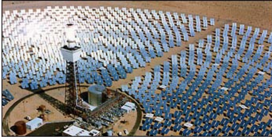
Figura 2.30 - Coletor concentrador solar de receptor central.
