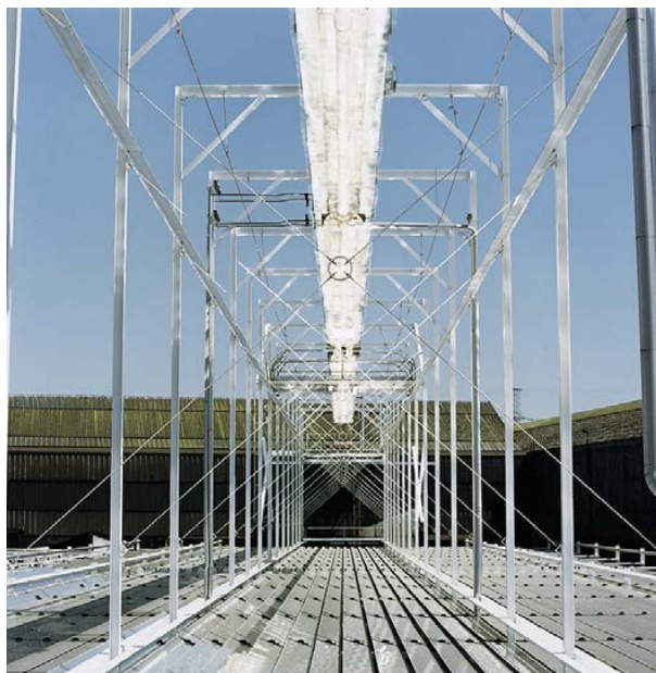
Figura 3.8 Coletor concentrador Fresnel, fornecido pela Solarmundo (IEA, 2005).
