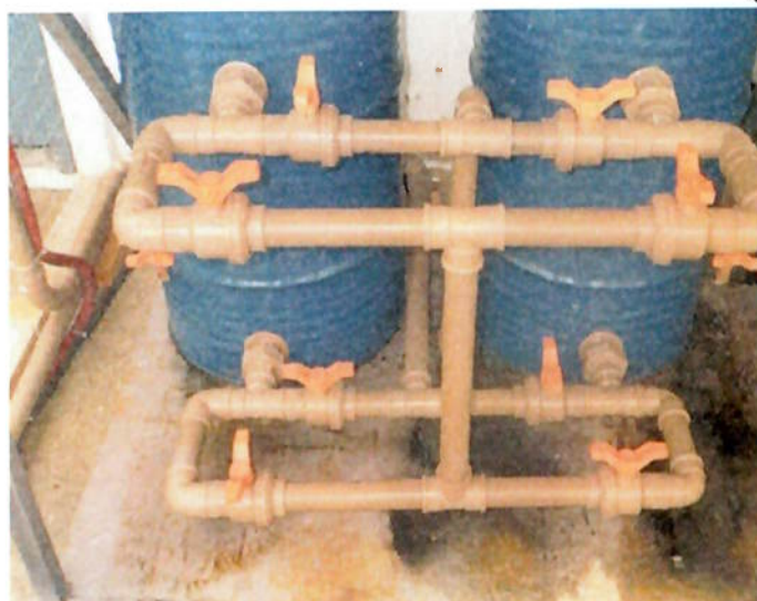
Figura 16: Filtro de carvão ativado, fase dissolvida. Fonte: projeto ANGEL.
