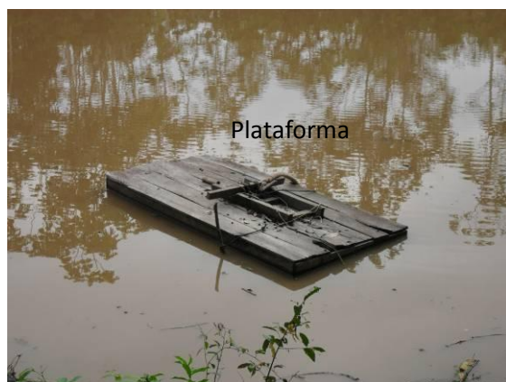
a) Bomba submersa fixada a plataforma flutuante
