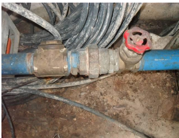
a) Válvula instalada no recalque
