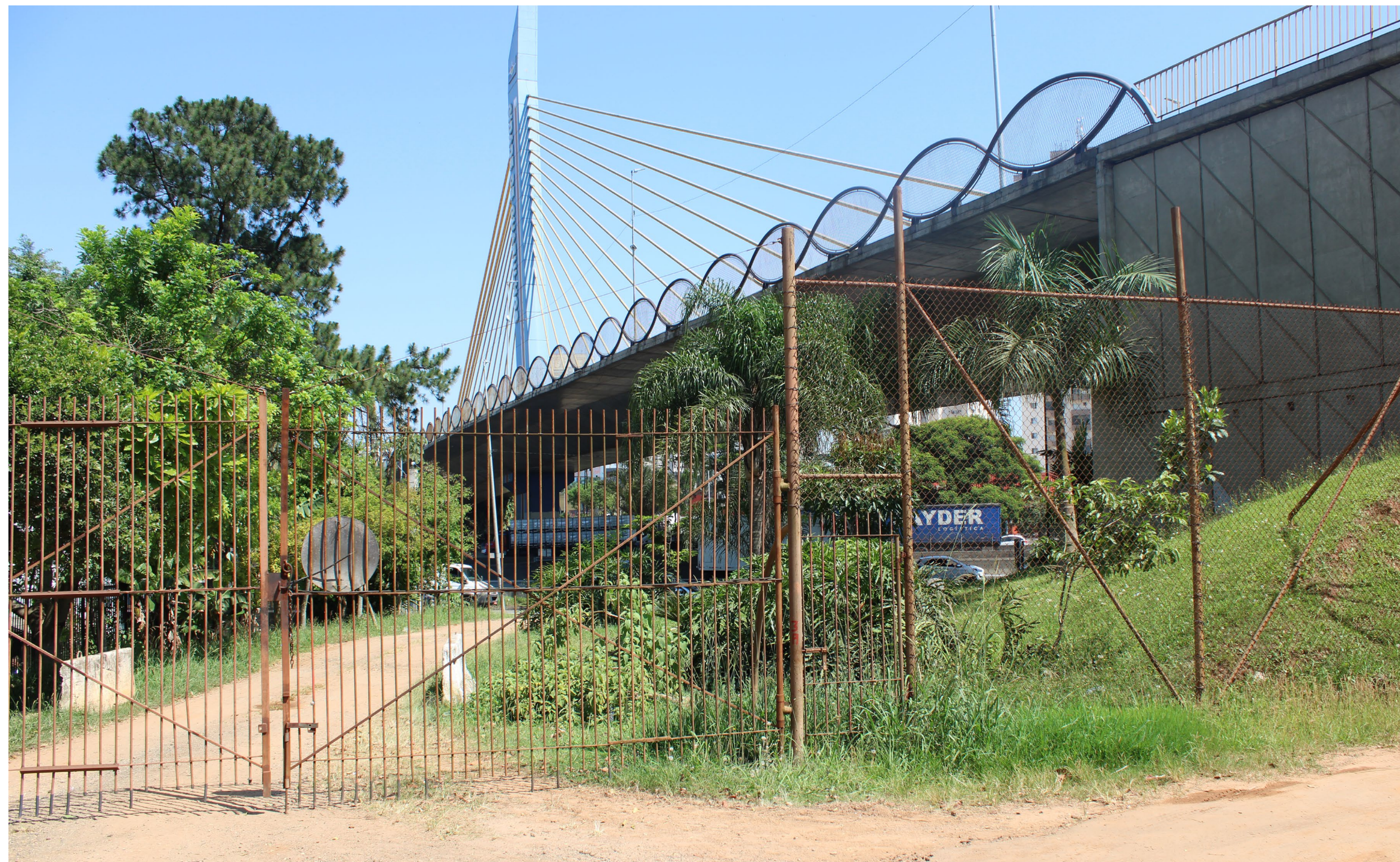
Figura 93: Fachada da Serraria Ecológica de Guarulhos. Fonte: Acervo pessoal.
