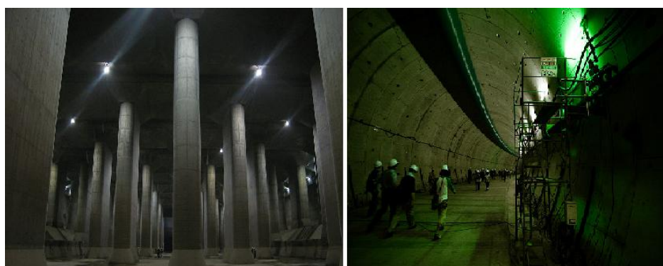
Figura 3B – G-Cans Project : Reservatório principal (esquerda) e túnel de interligação entre reservatórios (direita)
