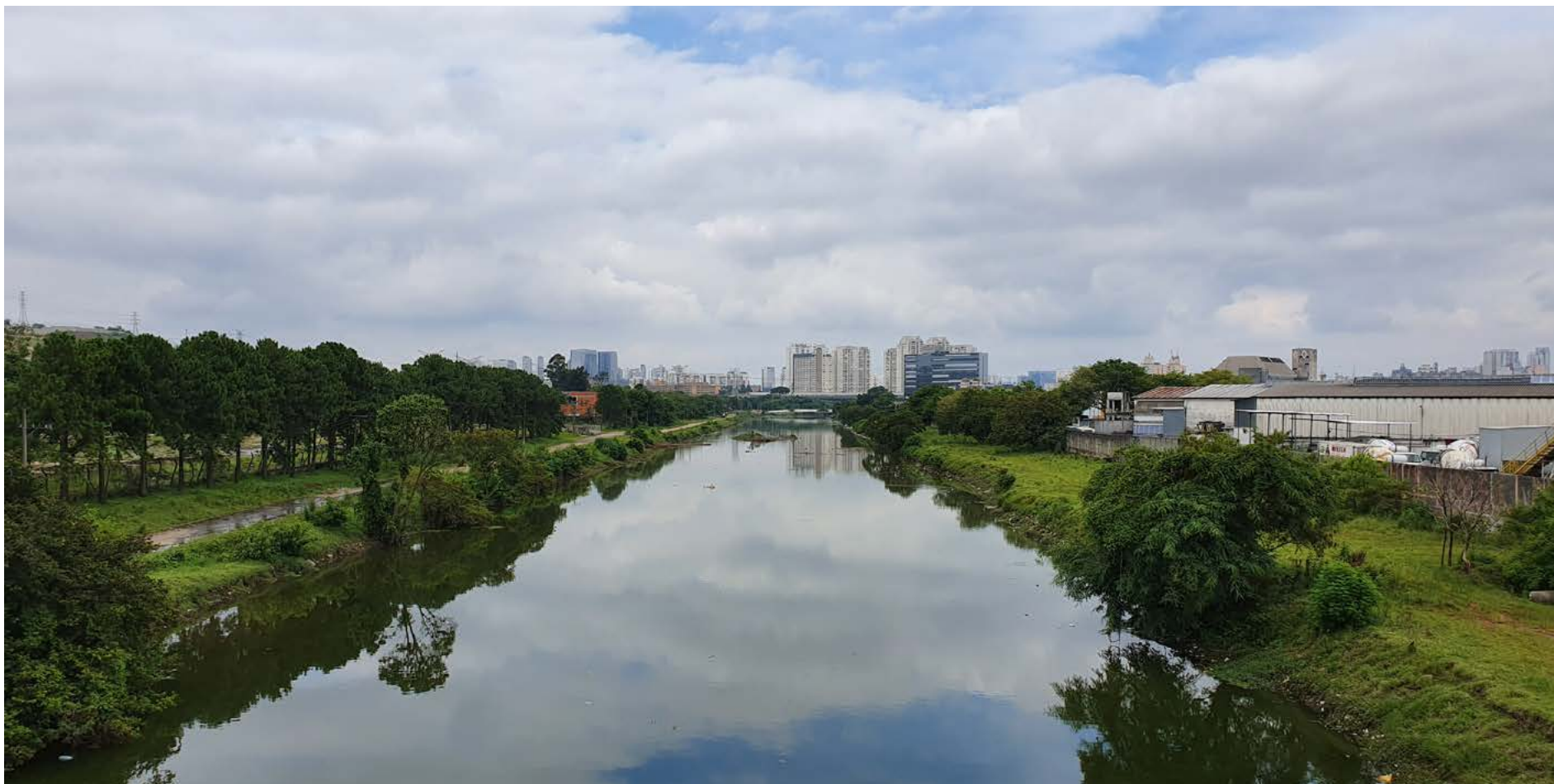
fig. 86 Canal Guarapiranga a partir da ponte, com a confluência com o Canal Jurubatuba ao fundo. Foto do autor em 09.01.2020.
