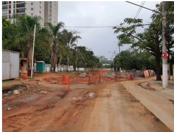
fig. 65 Duplicação da seção do Córrego Zavuvus em galerias, na Av. Eng. Alberto de Zagottis. Foto do autor em 14.11.2020.
