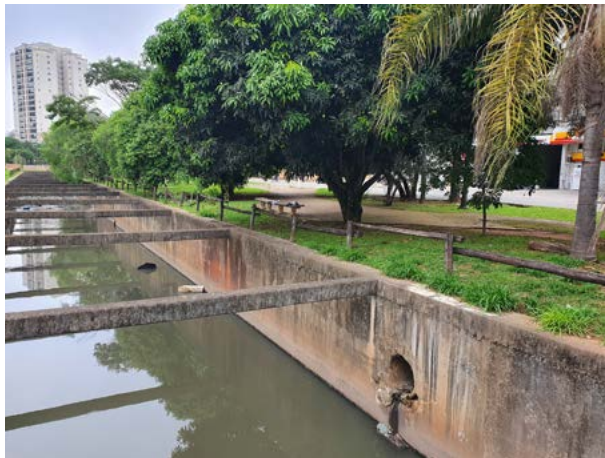
fig. 63 Trecho a céu aberto do Córrego Zavuvus próximo da Av. das Nações Unidas. Foto do autor em 14.11.2020.
