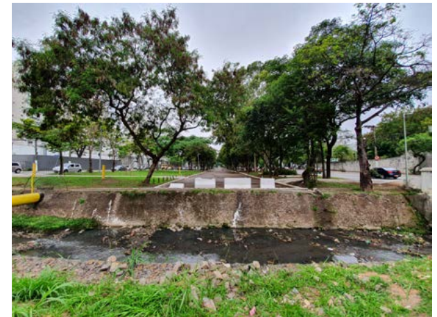
fig. 72 Passagem do Córrego Poty no canteiro central da Av. das Nações Unidas, com destaque para tubulação de gás. Foto do autor em 14.11.2020.
