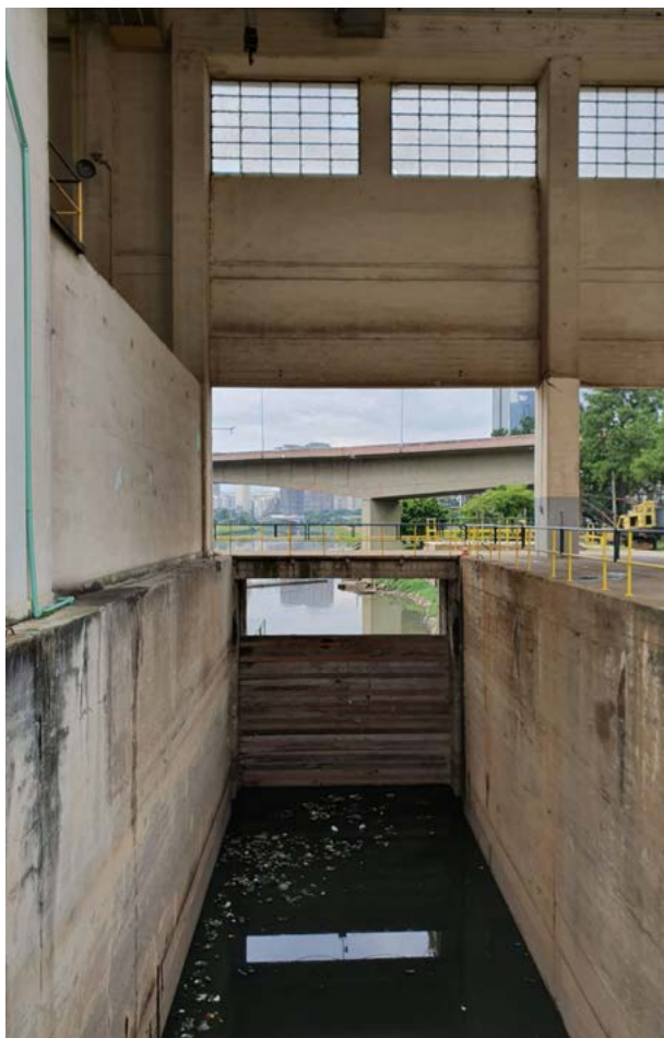
fig. 27 Câmara da eclusa na Estação Elevatória de Traição. Nível d'água do Pinheiros Inferior, que está atrás dos stoplogs , estruturas de madeira que hoje separa o desnível na câmara da eclusa. Foto do autor em 06.02.2020.
