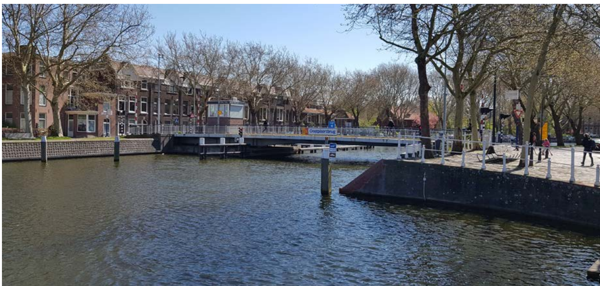
fig. 174 Oostportbrug , ponte móvel giratória com estrutura descentralizada em Delft. Tabuleiro: 10,00 x 30,00m Foto do autor em 10.04.2019.
