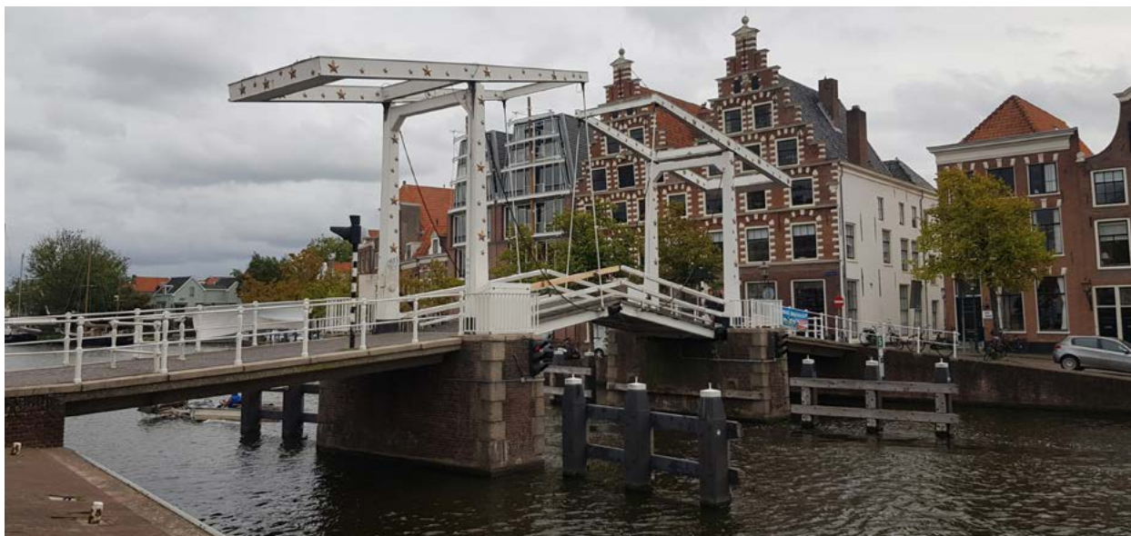
APÊNDICE O - Estudo de pontes móveis basculantes de dois tramos
