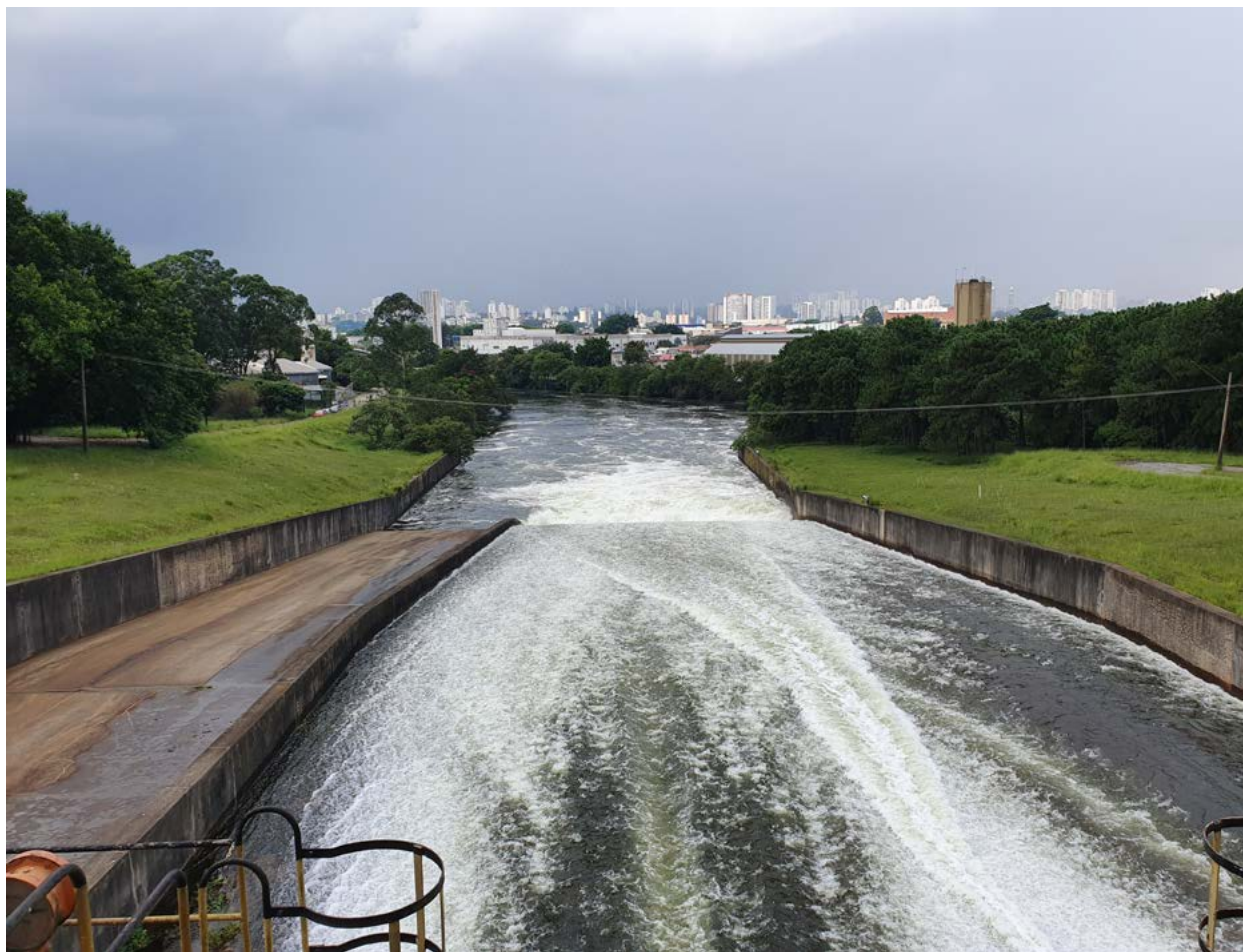
fig. 26 Operação de cheias do Reservatório Guarapiranga, com lançamento das águas da Represa para o Canal Guarapiranga, e consequentemente para o Pinheiros Superior. Foto do autor em 06.02.2020.
