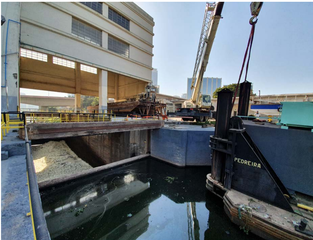
fig. 28 Vista da câmara da eclusa e situação junto ao prédio da Estação Elevatória. Foto do autor em 12.08.2020.
