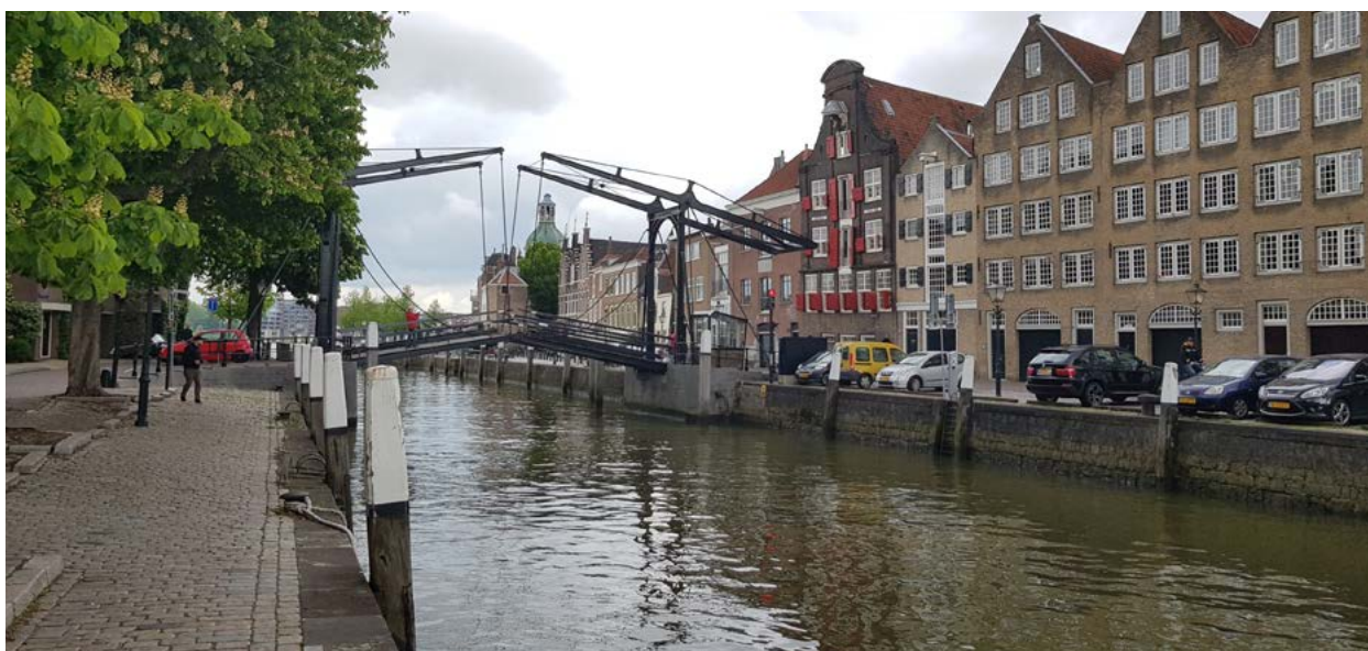
fig. 172 Gravestenbergbrug , ponte móvel basculante de dois tramos em Haarlem (Países Baixos). Foto do autor em 10.09.2018.
