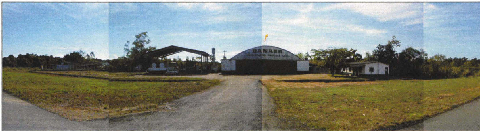
Foto 4. - Empresa de Pulverização e Área de Abastecimento Atual
